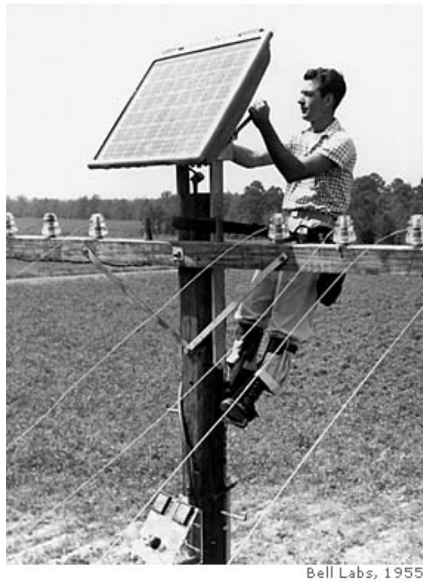
Figura 1: Instalação do primeiro painel solar 1955.
