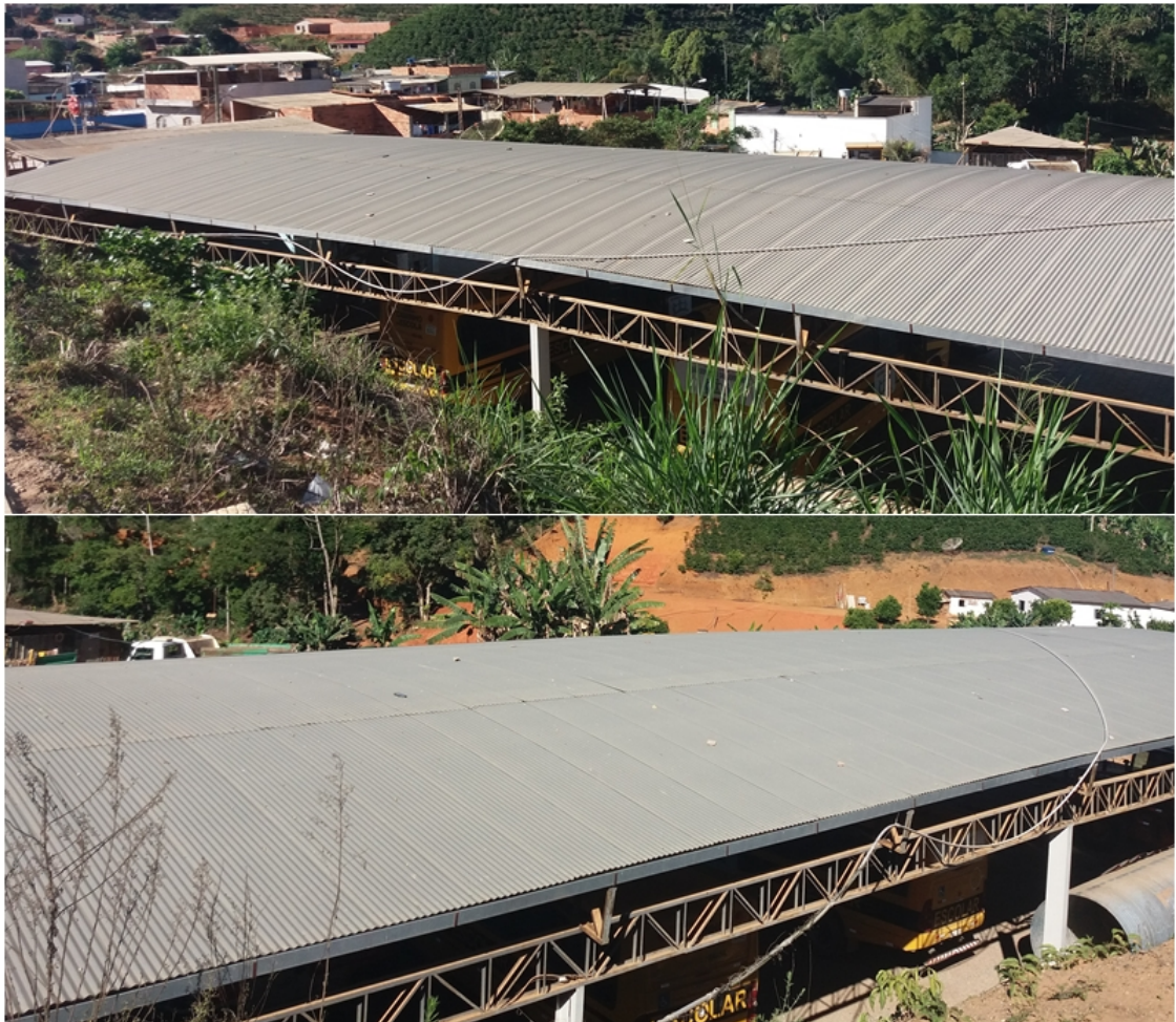
Figura 23: Foto do local escolhido para instalação do sistema fotovoltaico.
