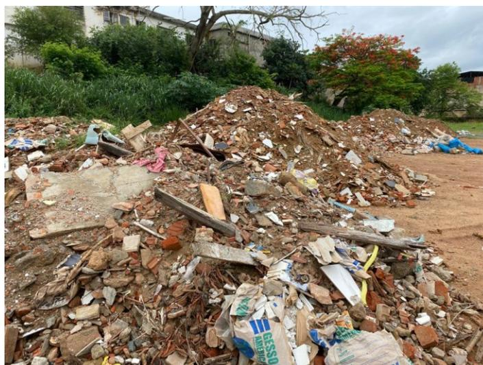
**FIGURA 01:** Disposição irregular dos resíduos da construção e demolição na cidade de Piraúba-MG.
