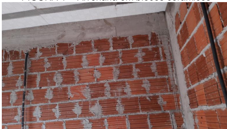
FIGURA 1 – Alvenaria em blocos cerâmicos
