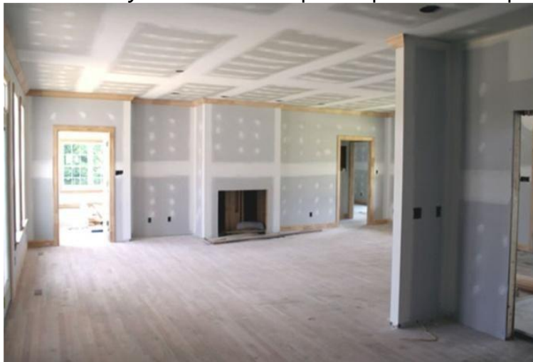
FIGURA 10 - Drywall instalado e pronto para receber pintura
