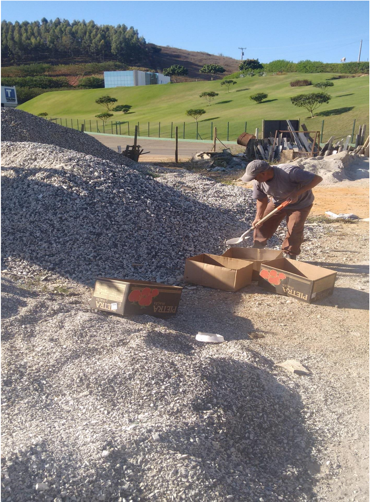
Brita feita a partir do resíduo do granito – Fonte: Autores, 2015
