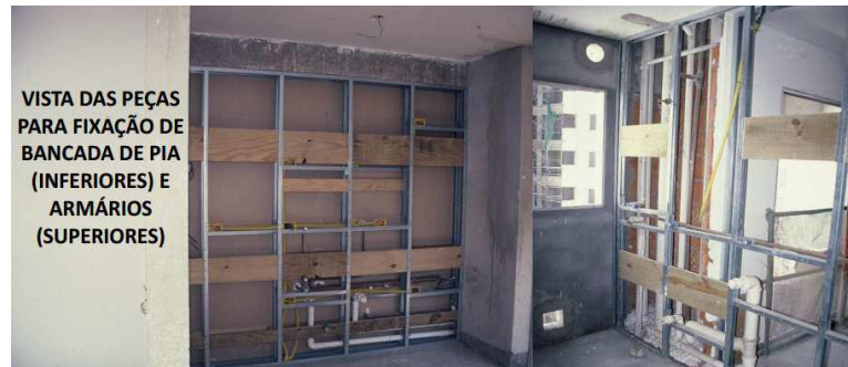
Figura 7 - Fixação de cargas em paredes
