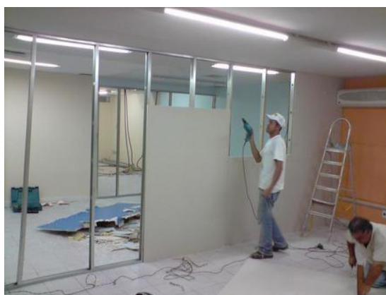
Figura 26 - Instalação de chapas drywall
