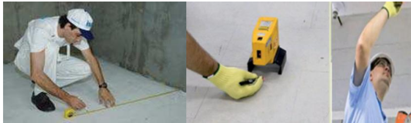
Figura 21 - Locação do posicionamento das paredes.
