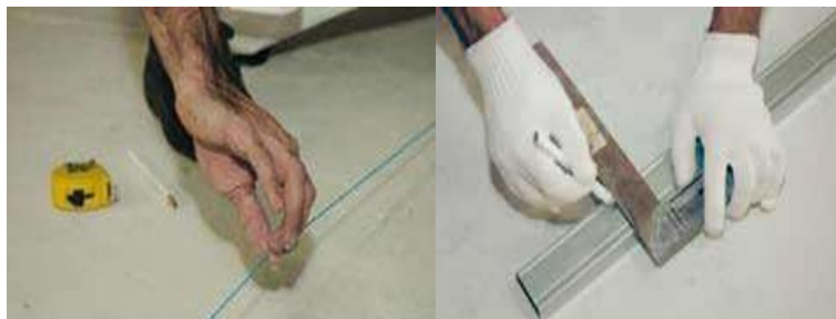
Figura 22 - Marcação da posição das guias
