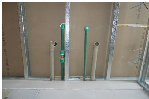
Figura 12 - Instalações Hidráulicas ( Drywall )
