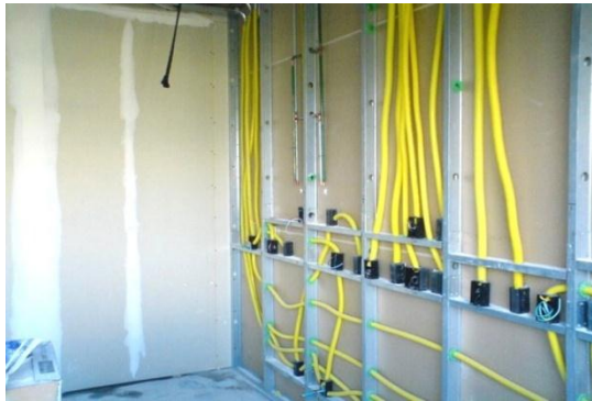
Figura 13 - Instalação elétrica em divisórias de gesso acartonado ( Drywall )
