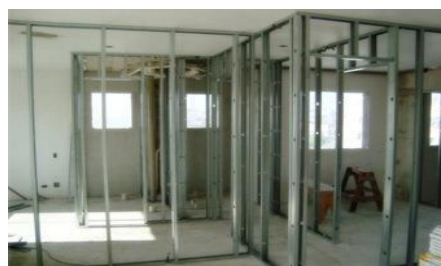
Figura 25 - Instalação de montante
