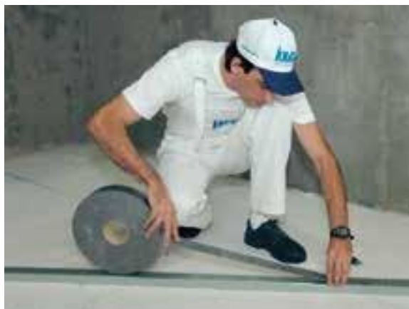
Figura 23 - Colocação da fita para isolamento nas guias
