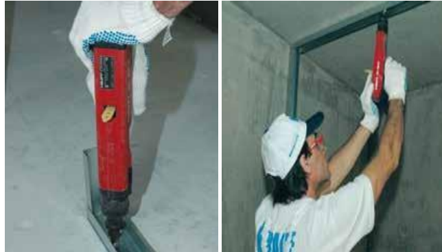
Figura 24 - Fixação de guias
