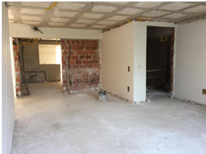
Figura 3: Aplicação de gesso direto na alvenaria
