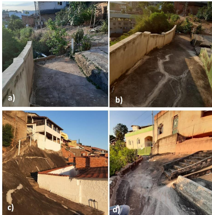
Figura 5. Riscos identificadas na Travessa Petronilio Riberiro. (Acervo do autor, 2019)
