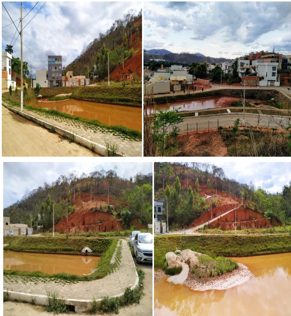
Figura 7- Bacia de drenagem
