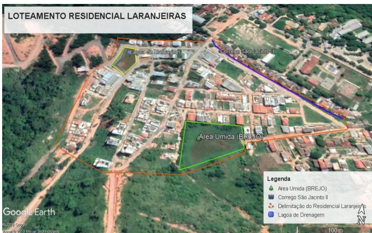
Figura 1: Vista aérea do Loteamento Residencial Laranjeiras em Teófilo Otoni.
