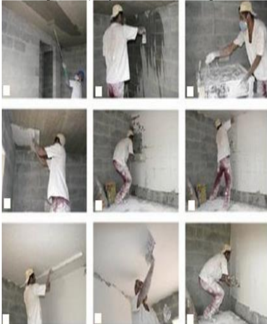
Figura 5 – Aplicação de revestimento em gesso
