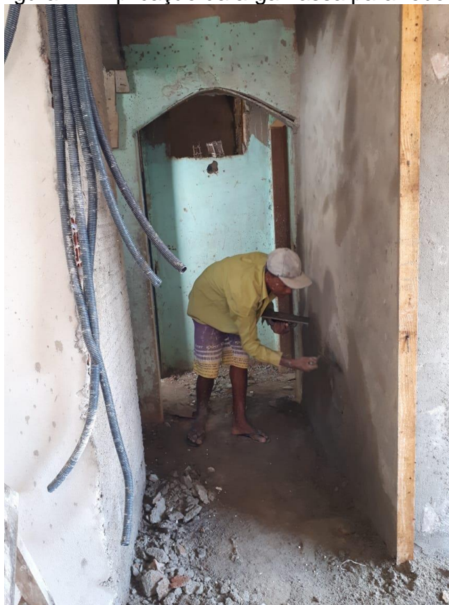
Figura 7 – Aplicação da argamassa para reboco
