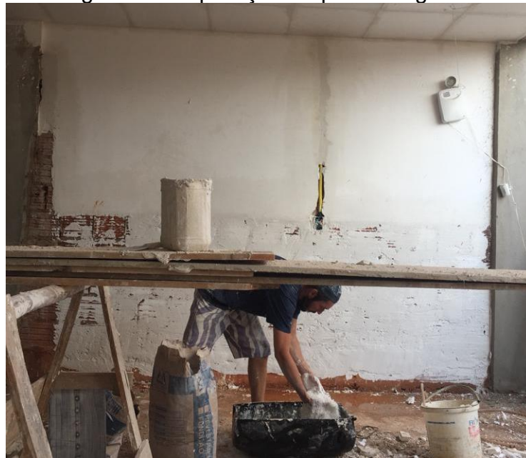
Figura 10 – Aplicação da pasta de gesso
