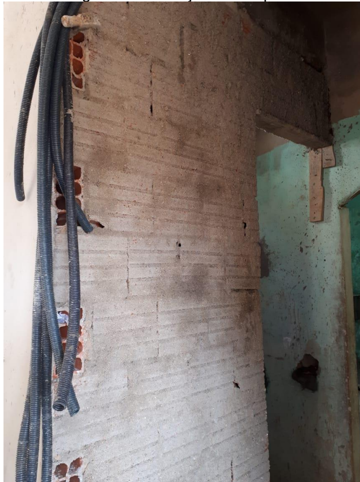
Figura 6 - Execução do chapisco
