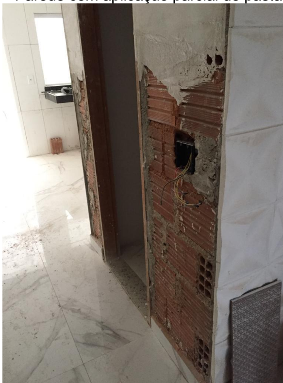
Figura 9 – Parede com aplicação parcial de pasta de gesso
