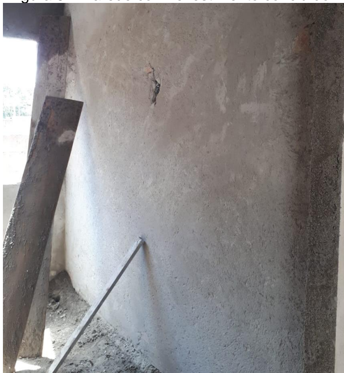
Figura 8 – Parede com revestimento concluído
