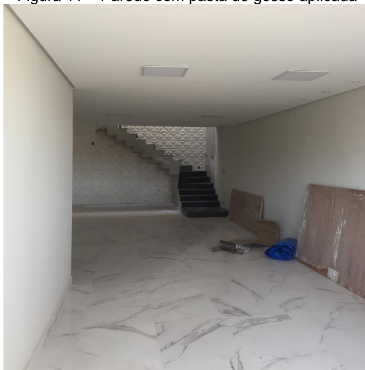
Figura 11 – Parede com pasta de gesso aplicada
