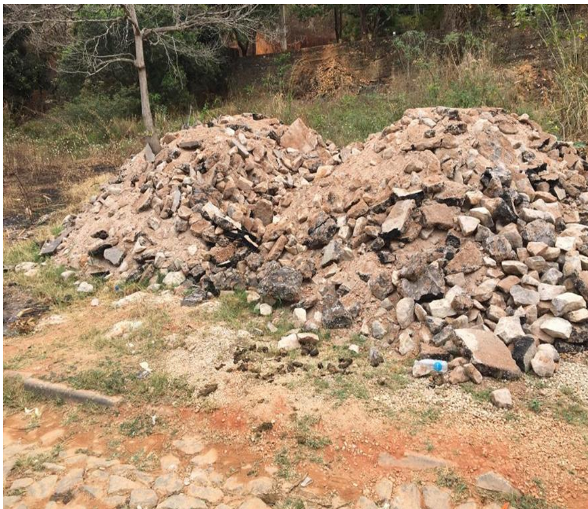
Figura 23 - Volume de RCD de forma irregular na rua Olga Correa pertencente ao bairro Dr. Laerte Laender, na cidade de Teófilo Otoni – MG
