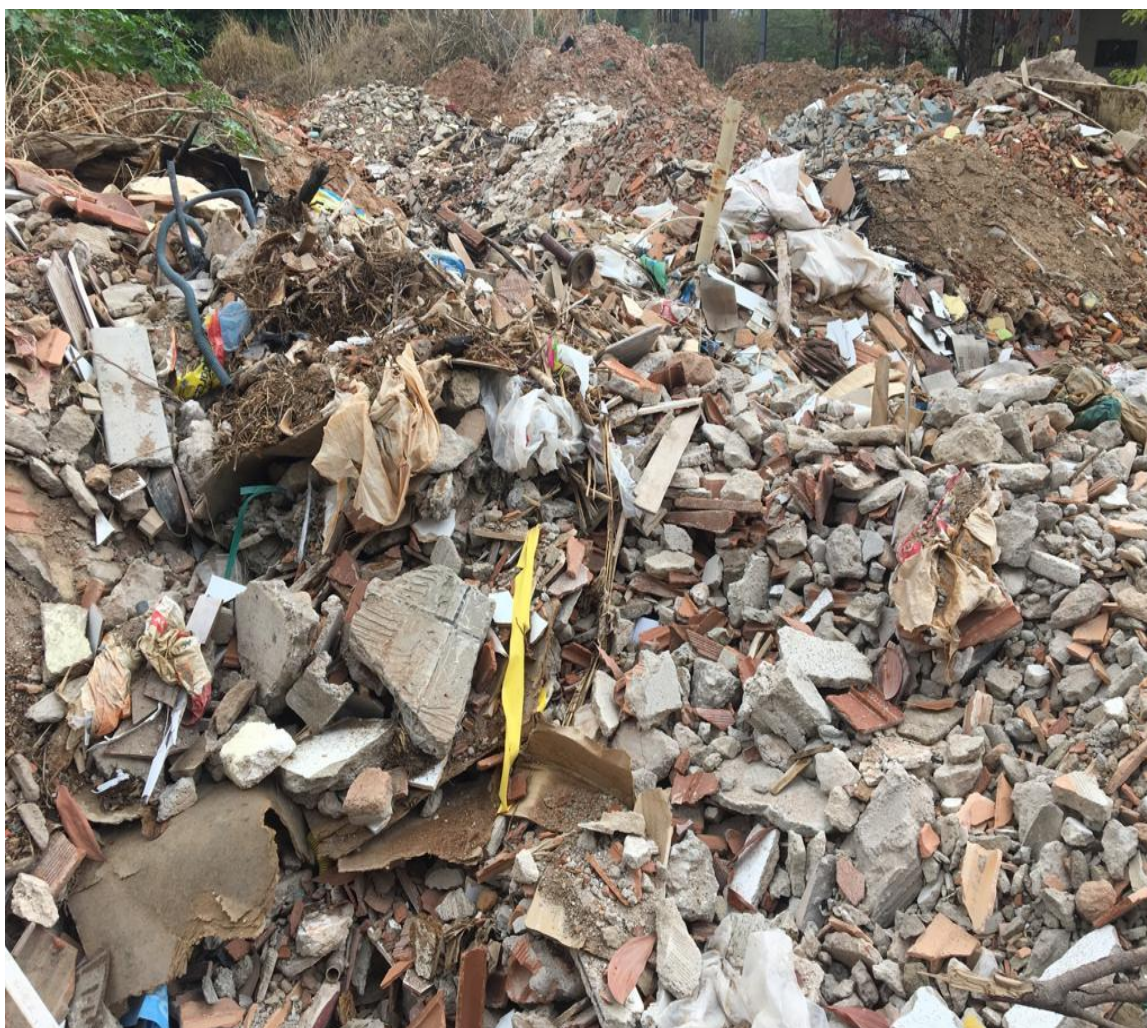
Figura 17 - Volumes de RCD evidenciados de forma irregular na rua Ewald Middelfor do bairro Jardim Floresta, da cidade de Teófilo Otoni – MG
