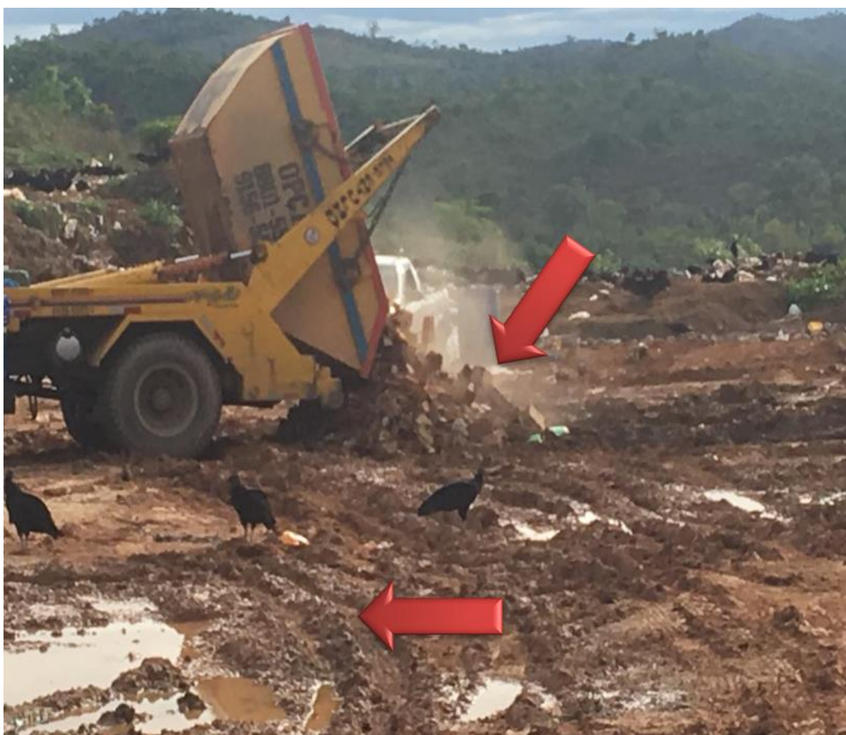
Figura 14 - RCD usado para compacta o solo do depósito de resíduos a céu aberto da cidade de Teófilo Otoni – MG
