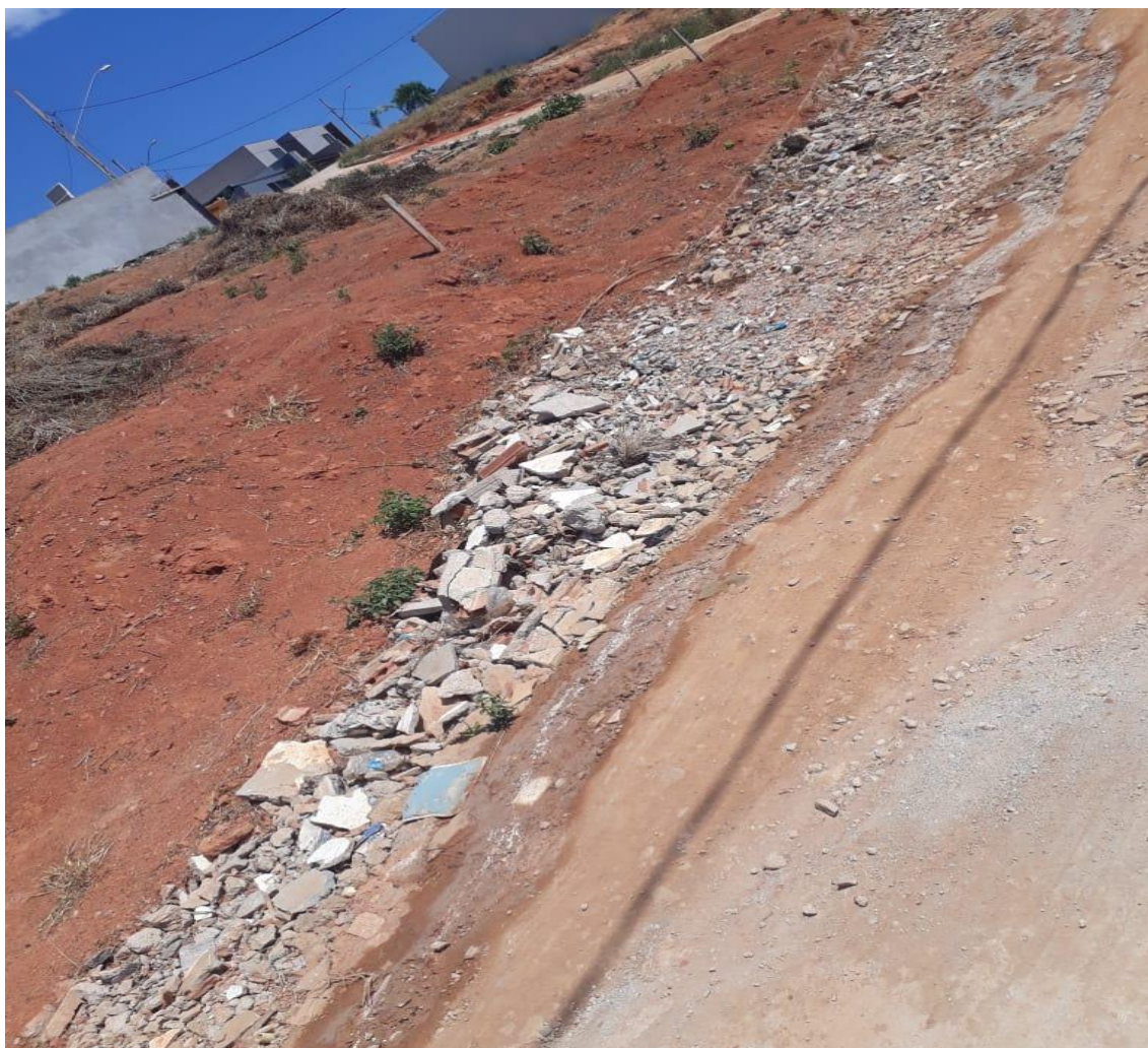
Figura 31 – Volumes irregulares de RCD encontrados na rua Marcos Jose Miglio Gazzinelli pertencente ao bairro Jardim Iracema, na cidade de Teófilo Otoni – MG
