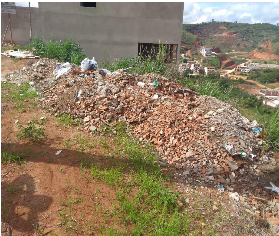
Figura 32 - Volume de RCD evidenciado de forma irregular na rua Carlos Alberto da Cunha Melo referente ao bairro Marajoara, na cidade de Teófilo Otoni – MG
