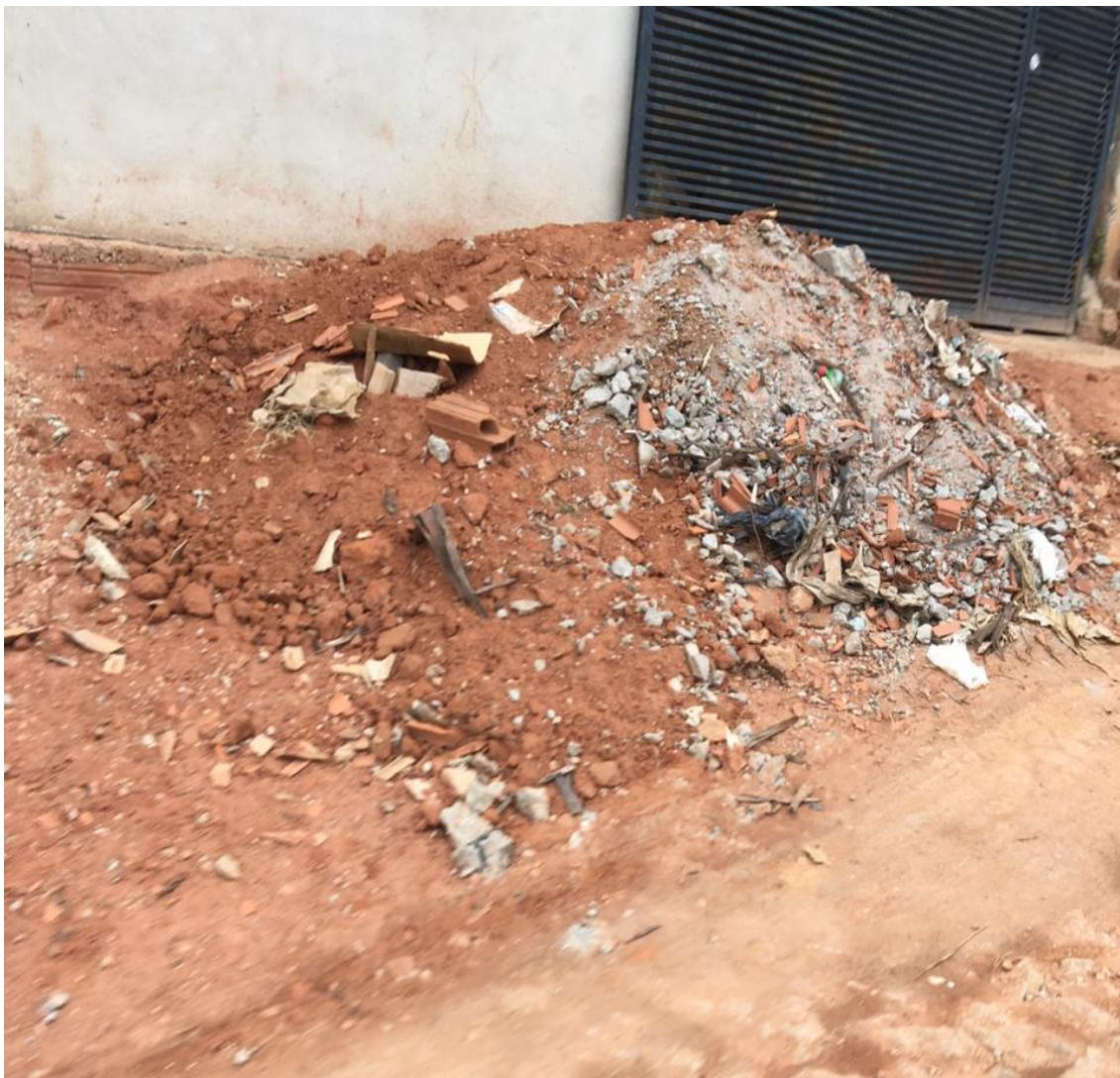
Figura 26 - Volume de RCD evidenciado de forma irregular na rua Alberto Barreiros situado no bairro Vila Barreiros, na cidade de Teófilo Otoni – MG
