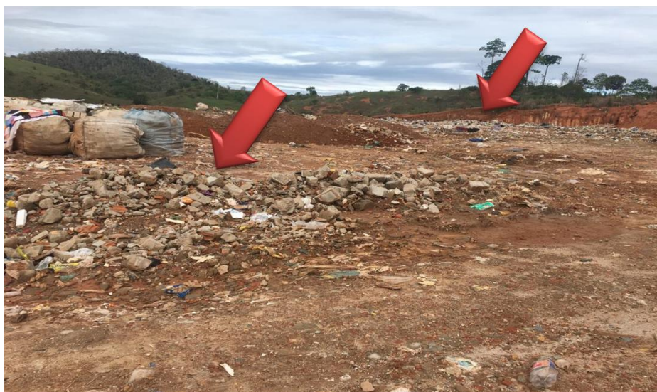
Figura 11 - Depósito de resíduos a céu aberto como lugar de disposição de RCD
