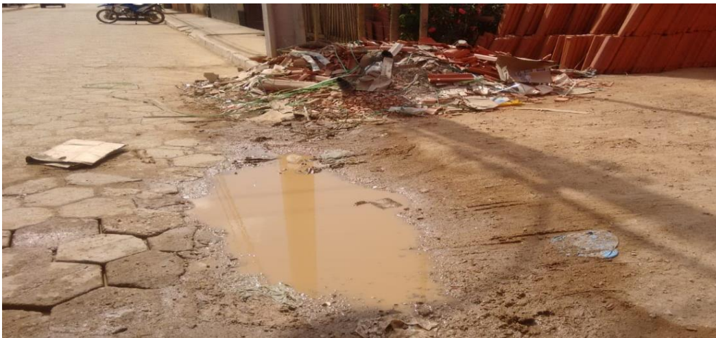
Figura 2 - RCD disposto em uma calçada gerando impactos negativos
