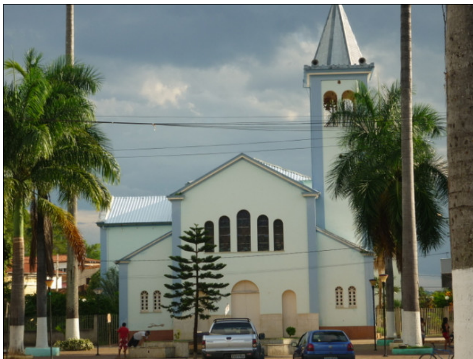
FIGURA 06: Fachada da Igreja
