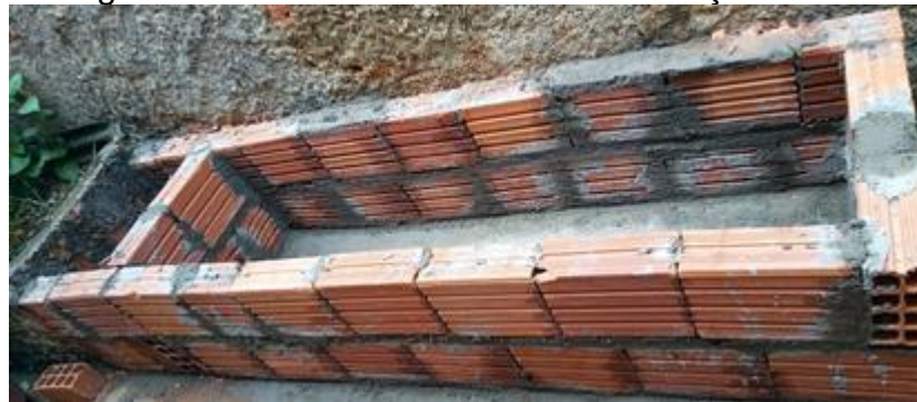
Figura 3.2- Visão do sistema em construção
