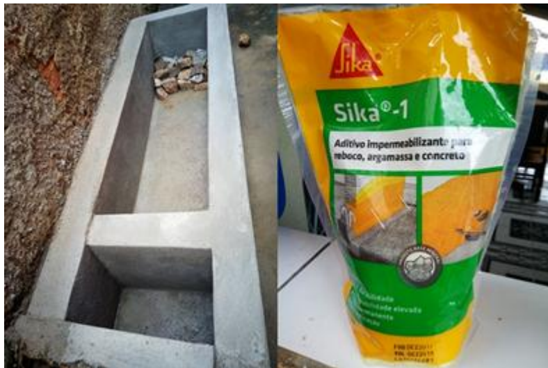
Figura 3.3- Visão do reservatório após o reboco e a aplicação da Sika-1
