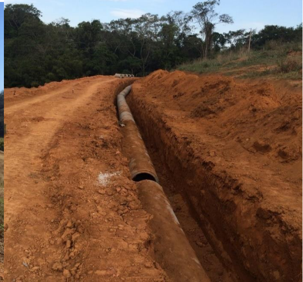
Figura 3- Construção Loteamento Alto Sereno
