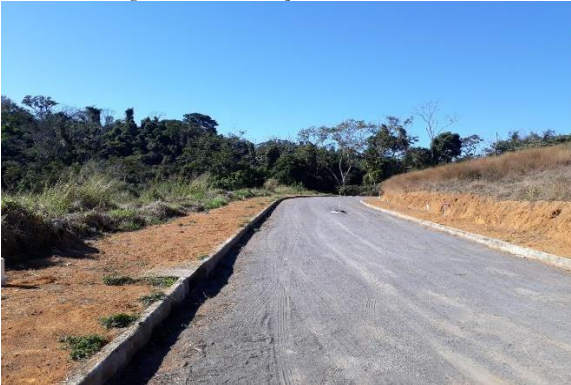
Figura 4- Construção Loteamento Alto Sereno
