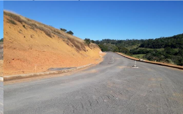
Figura 5- Construção Loteamento Alto Sereno
