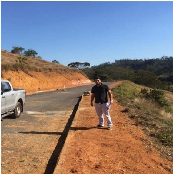
Figura 2- Construção Loteamento Alto Sereno
