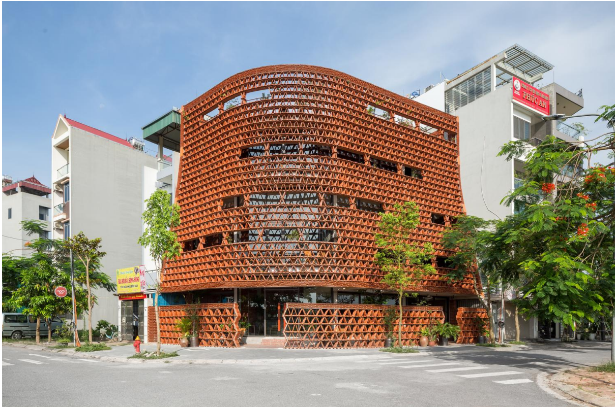
Figura 4: Fachada frontal do Espaço Coletivo Ngói.
