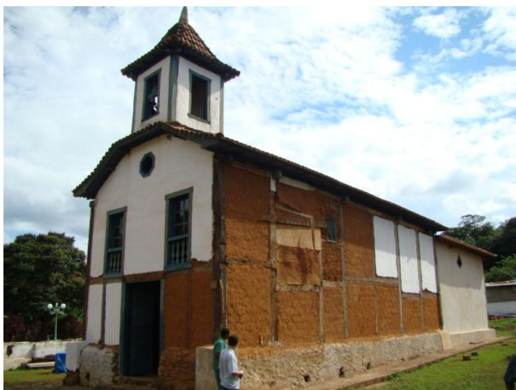
Figura 2: Igreja Nossa Senhora Mãe Augusta do Socorro.
