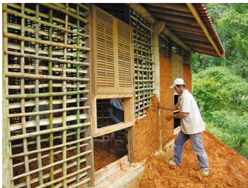
FIGURA2: construção de parede de pau a pique.
