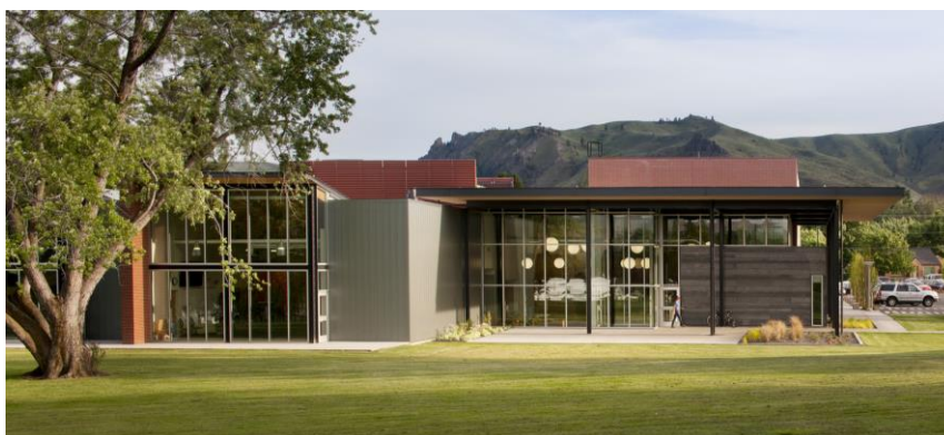
Figura 5: Imagem da fachada norte
