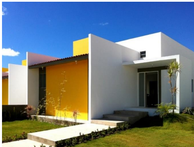
Figura 3- Fachada da edificação.
