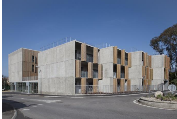
Figura 1- Fachada da edificação
