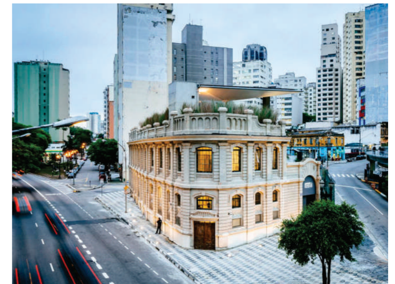
Figura 3: Red Bull Station, São Paulo, após o processo de retrofit, financiado pela Red bull.
