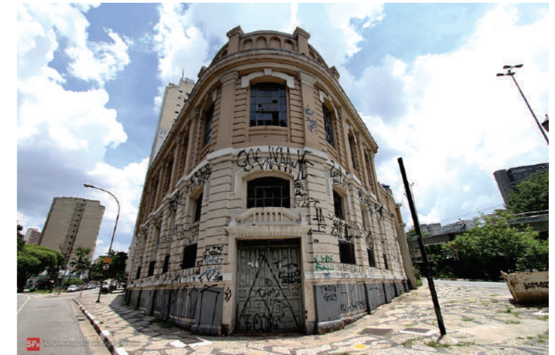
Figura 2: Fachada do Prédio da Subestação Riachuelo antes do processo de retrofit.
