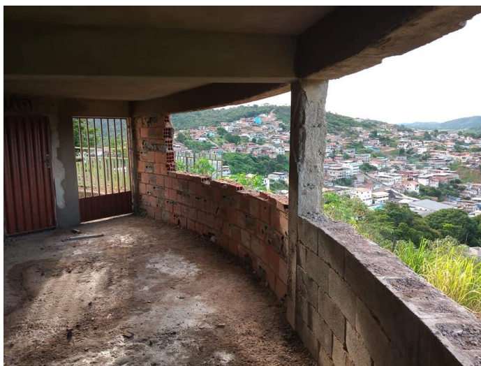
Imagem 6: Processo de Reforma do Interior da Parte Inferior do Mirante.
