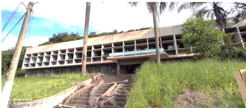
Figura 1: Foto da entrada principal da escola Santana, onde podemos ver parte de sua volumetria e o seu atual estado de conservação. Foto: Thaís Mara
