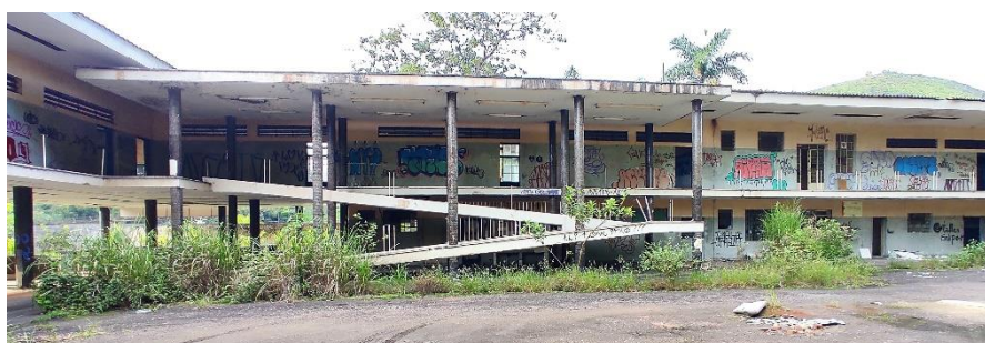
Figura 2: Foto da parte posterior da Escola, mostrando a rampa de acesso ao nível superior, o pátio central e os pilotis que fazem referência aos cinco pontos da arquitetura de Le Corbusier. Foto: Thaís Mara
