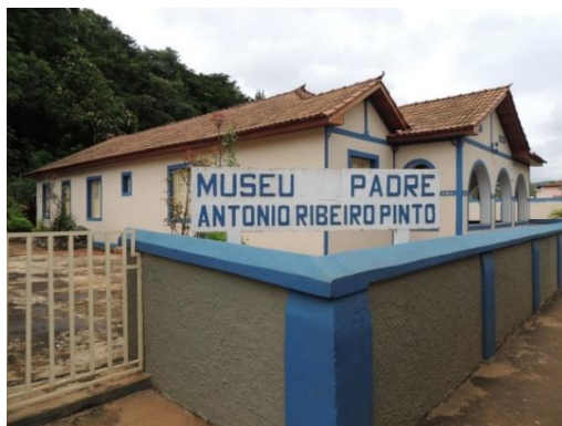
Figura 01 Fachada lateral esquerda
