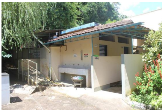
Figura 8: banheiro e Bebedouro descaracterizado no entorno do museu
