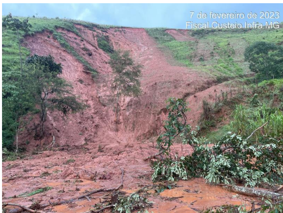
Figura 16- Foto do material proveniente da erosão
