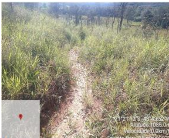
Figura 9- Limpeza de Vala não revestida (antes)
