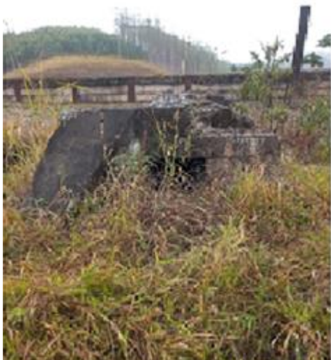
Figura 5- Limpeza de Bueiros (antes)
