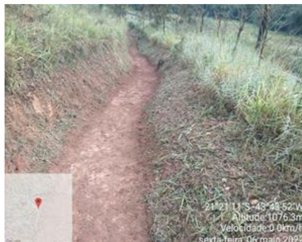
Figura 10- Limpeza de Vala não revestida (depois)
