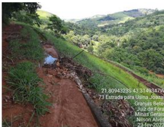
Figura 7- Limpeza de Canaleta (antes)
