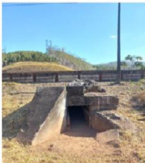
Figura 6- Limpeza de Bueiros (Depois)
