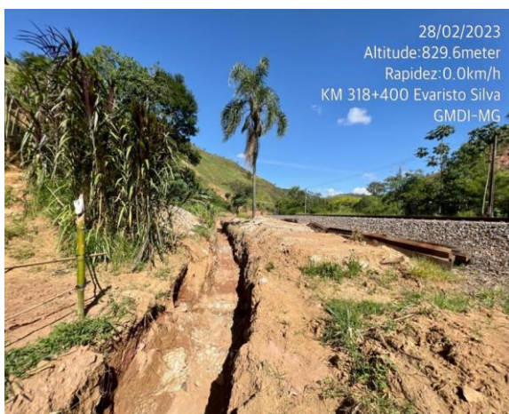
Figura 22- Abertura de vala mecanizada
