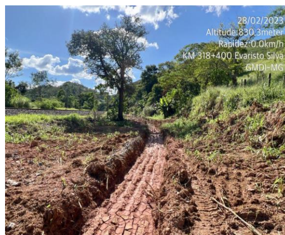
Figura 23- Abertura de vala mecanizada
