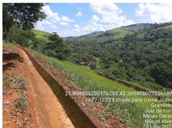
Figura 8- Limpeza de Canaleta (depois)
