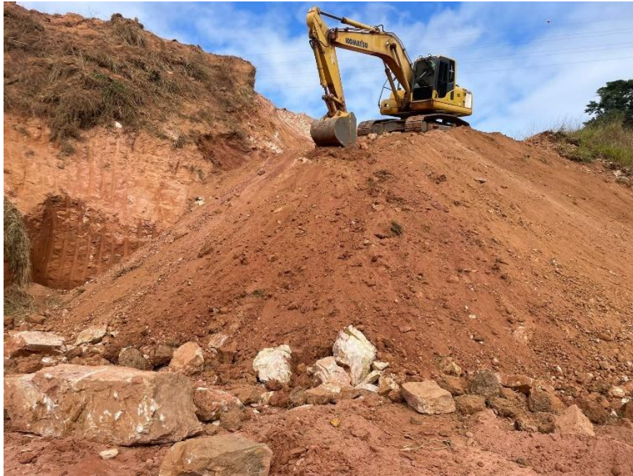
Figura 4: Escavadeira executando corte de talude
