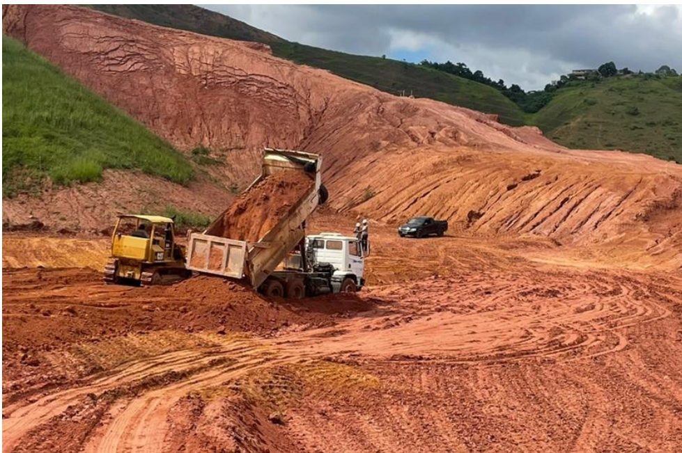
Figura 3: Descarregamento de caminhão basculante em área de aterro.
