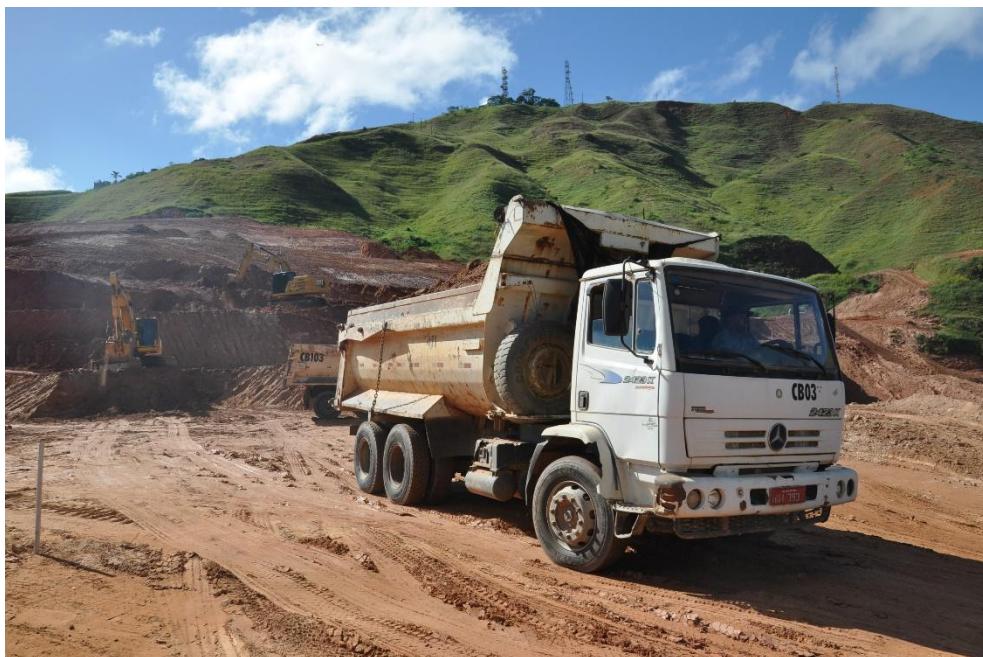
Figura 2: Manobra de caminhão basculante de 10 m 3
