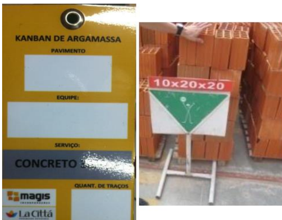
Figura 9 Exemplo de utilização do Kanban em obras
