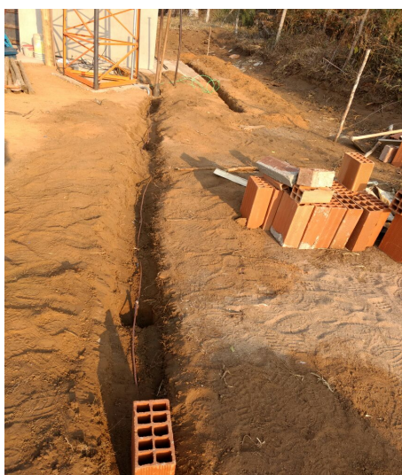
Figura 45: Hastes de aterramento existente no local.
