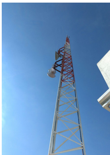
Figura 42: Torre metálica existente no local.
