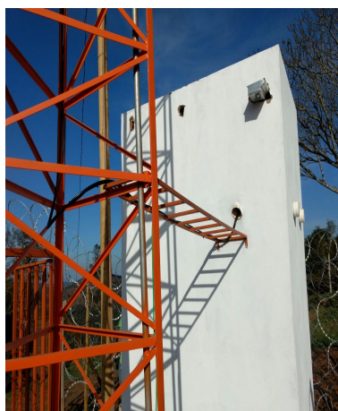
Figura 43: Abrigo existente no local.
