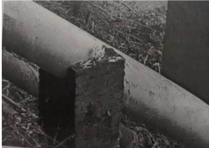
Figura 14 - Exemplo de Bloco para ancoragem na tubulação
