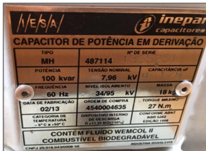
**Figura 13:** Dados elétricos do capacitor instalado.
