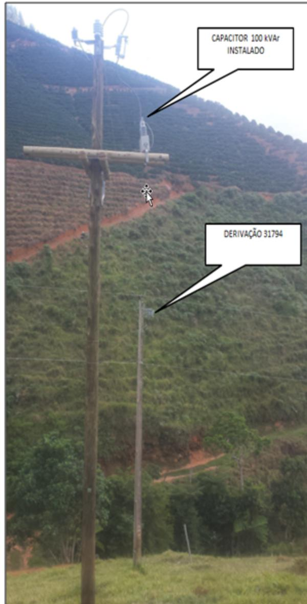
**Figura 14:** Capacitor instalado
