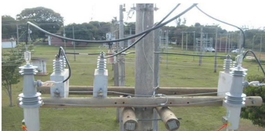
**Figura 7:** Banco de capacitores automáticos
