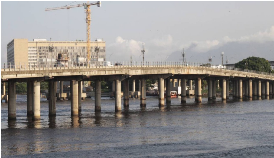
Figura 1: Ponte do Galeão-RJ. Calculada por Eugène Freyssinet, em 1948
