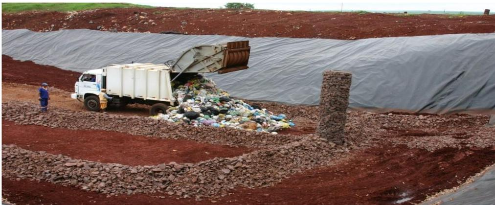
Figura 03. Aterro sanitário em funcionamento. Fonte: <http://vidaenatureza.com.br/?p=2828> - Acesso em 21 de maio de 2016.
