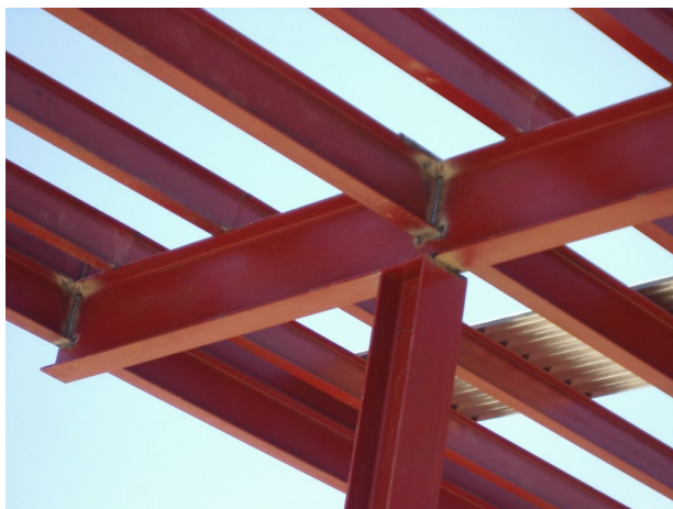
Figura 7: Vigas e pilares soldados.
