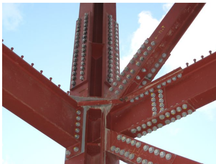
Figura 8: Vigas e pilares parafusados.
