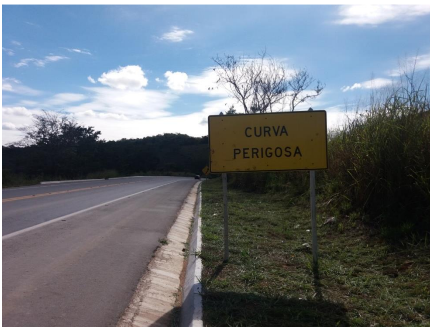
Placa de advertência a 500 metros da curva 66.
