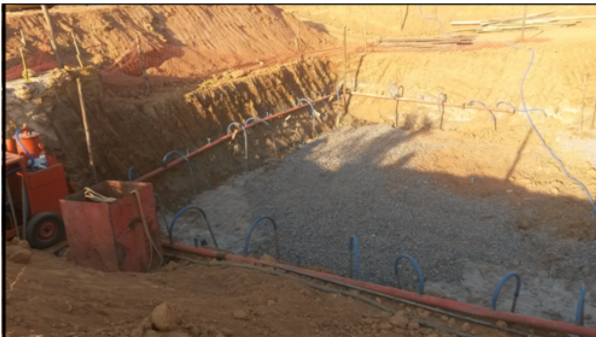
Figura 39: Espaçamento das ponteiras.
