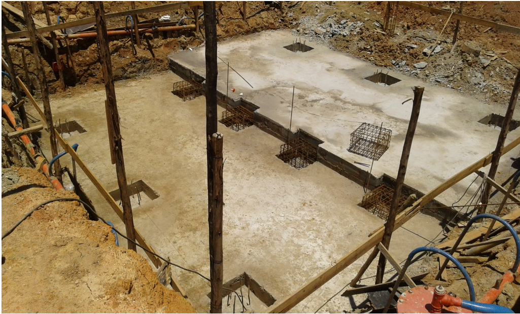
Figura 50: Execução da parte inferior da elevatória. Fonte: Arquivo do Autor.
