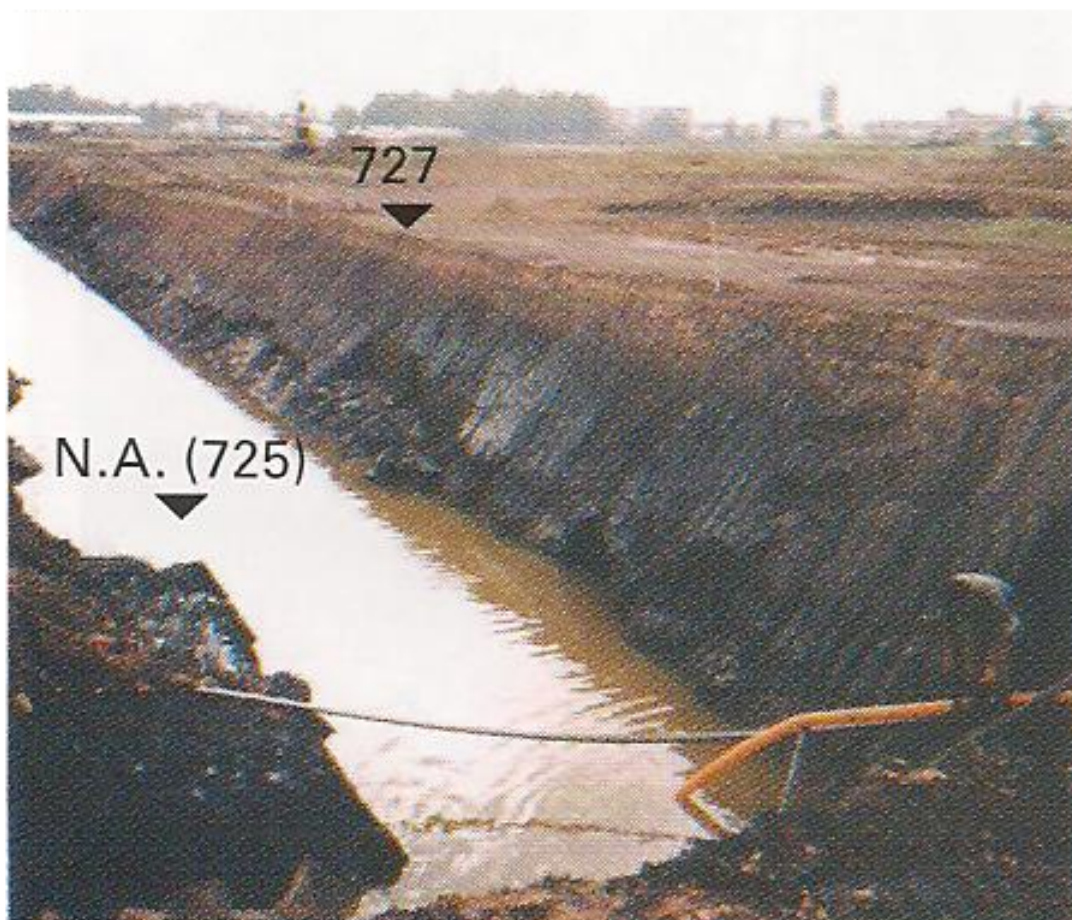
Figura 3: Bomba instalada no fundo da vala. Fonte: Alonso(2007).
