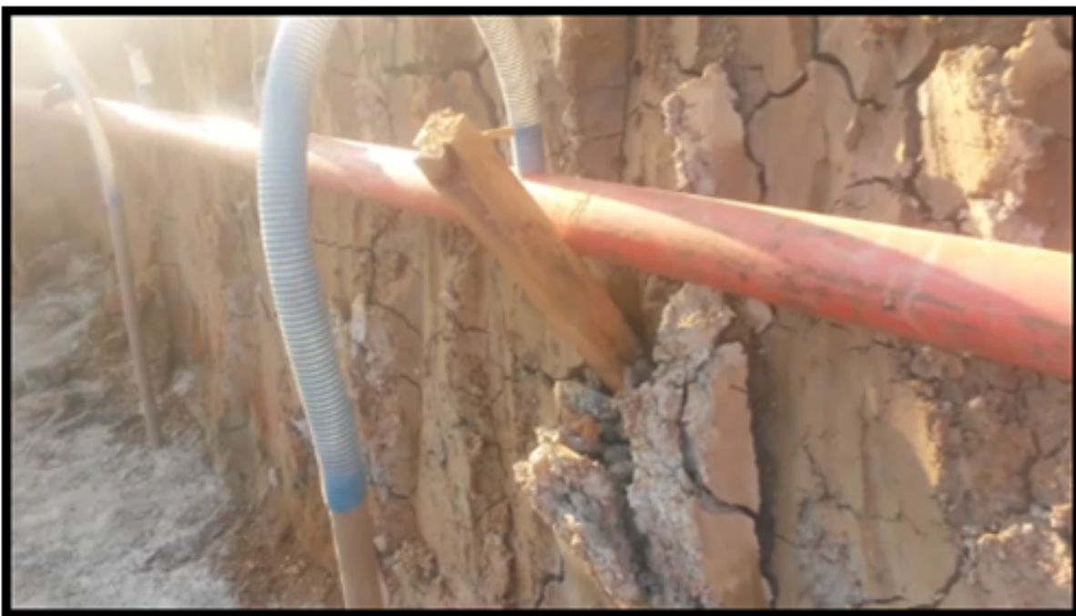
Figura 40: Mangueira de ligação entre a ponteira e o tubo coletor.
