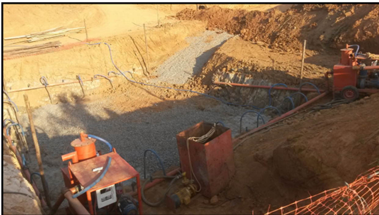
Figura 42: Instalação da bomba de vácuo.
