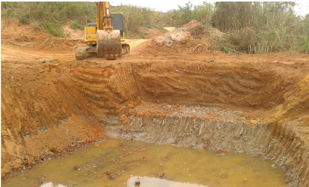
Figura 45: Escavadeira hidraulica durante a escavação da vala.
