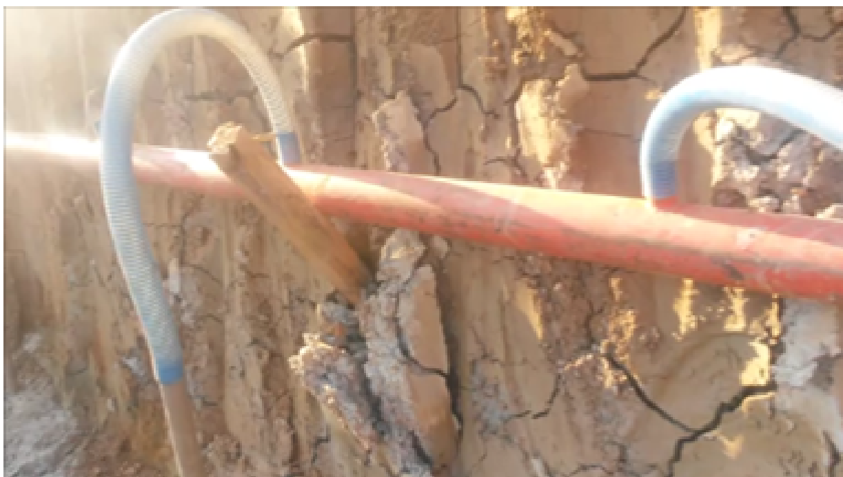
Figura 14: Mangote de ligação da ponteira com o tubo coletor.
