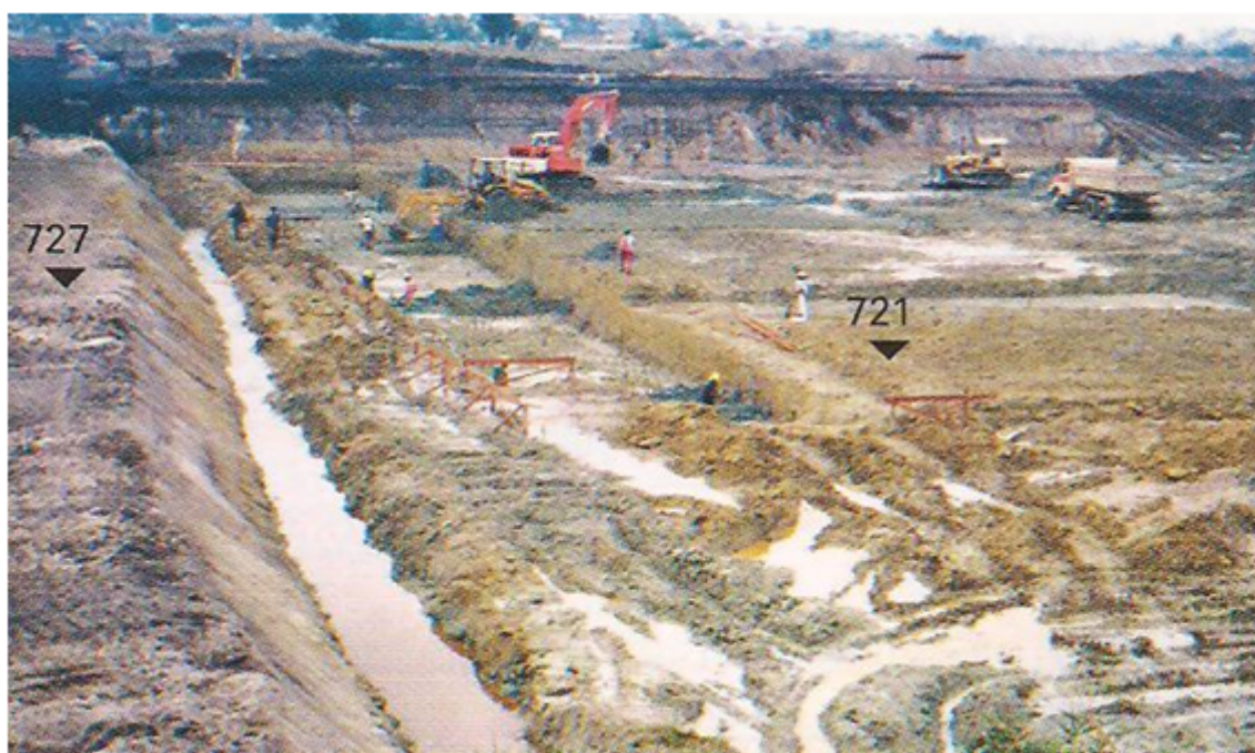
Figura 4: Exemplo de execução de rebaixamento por bombeamento direto. Fonte: Alonso(2007).
