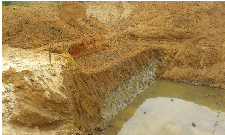
Figura 35: Nível d'água exposto após a escavação.
