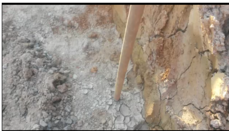
Figura 47: Tubo selado com argila.
