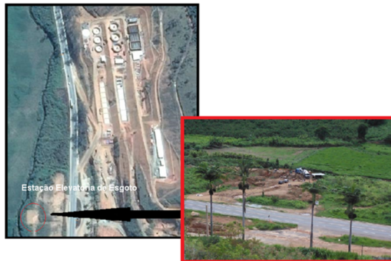
Figura 34: Vista aérea da Estação Elevatória de Esgoto nº3 (ainda em construção).
