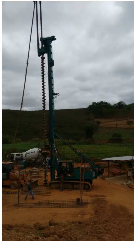
Figura 48: Equipamento de perfuração de hélice contínua. Fonte: Arquivo do Autor.
