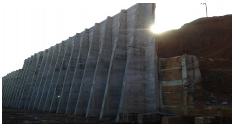
Figura 23: Muro de concreto
