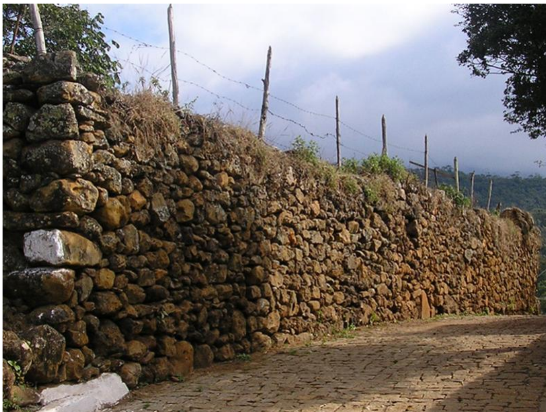
Figura 19: Muro de Pedra Seca
