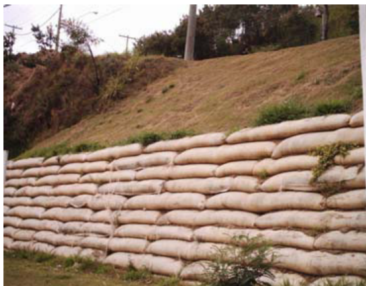
Figura 18: Muro de solo ensacado
