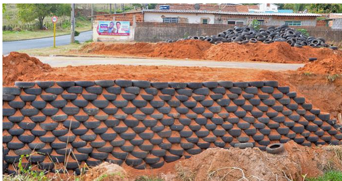
Figura 20: Muro de Pneus
