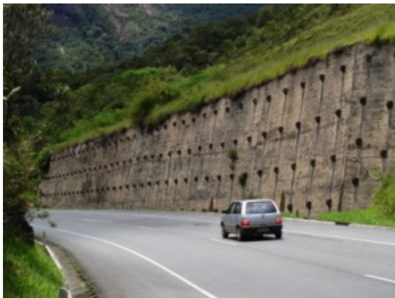
Figura 24: Conteção de encosta com cortina atirantada
