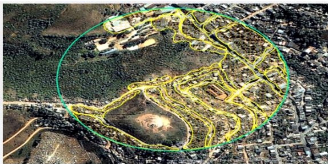
Figura 13: Área construída na área de risco
