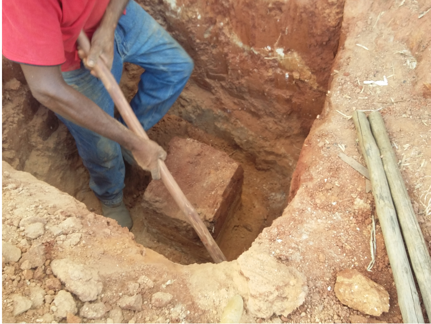
Figura 38: Procedimento de escavação da trincheira
