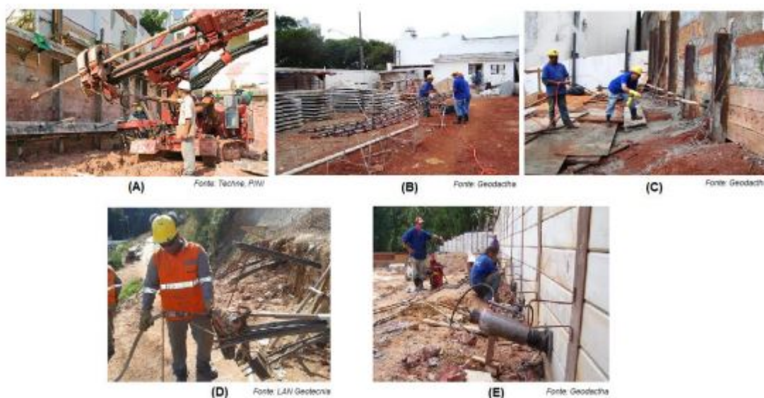
Figura 25: Etapas executivas de tirantes. (A) Perfuração; (B) Montagem; (C) Instalação; (D) Injeção; (E) Protensão.
