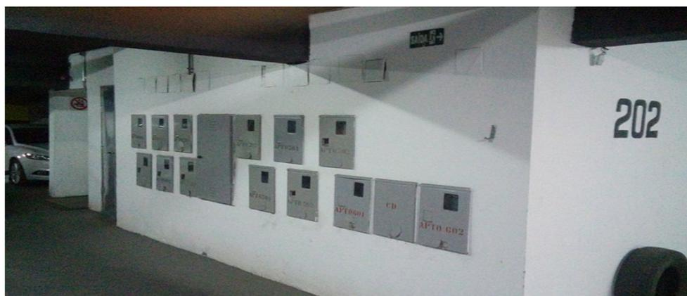
**Figura 21:** Detalhe do local da caixa de equipotencial.
