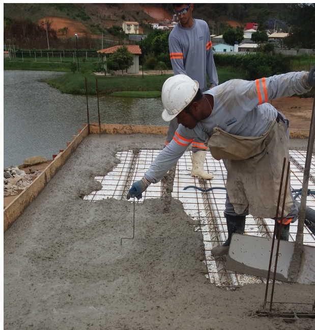
Figura 20: Nivelamento do concreto da obra estudada FONTE: Acervo das autoras.
