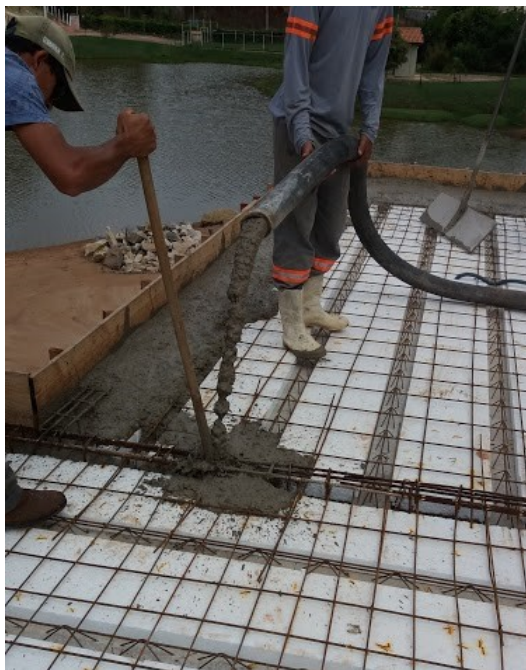
Figura 18: Lançamento e Adensamento do concreto da obra estudada FONTE: Acervo das autoras.
