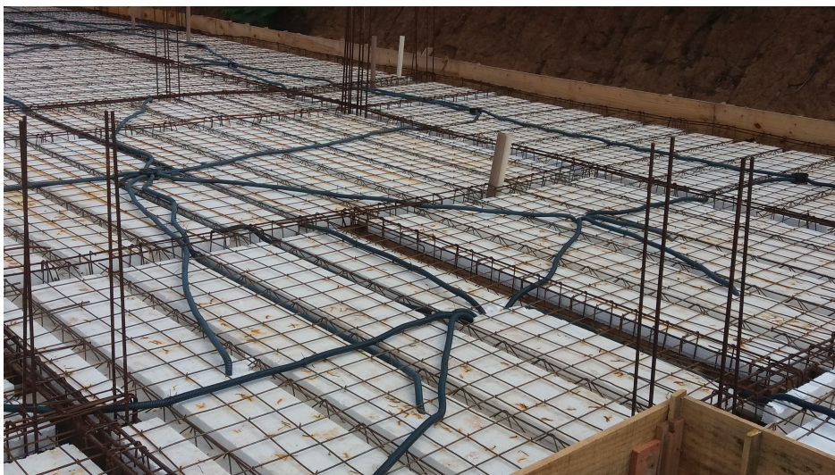
Figura 10: Armaduras da laje da obra estudada
