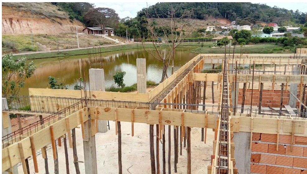
Figura 11: Armação de fôrmas da obra estudada
