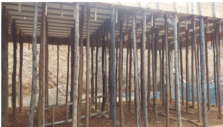
Figura 13: Escoramento da obra estudada FONTE: Acervo das autoras.
