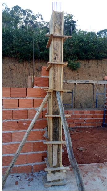
Figura 12: Fôrma de pilar da obra estudada FONTE: Acervo das autoras.
