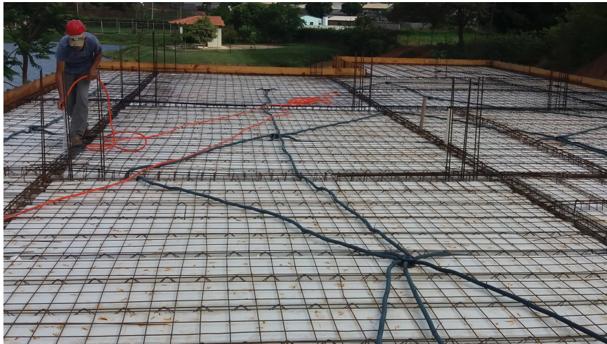
Figura 17: Fôrma sendo umidificada da obra estudada FONTE: Acervo das autoras.
