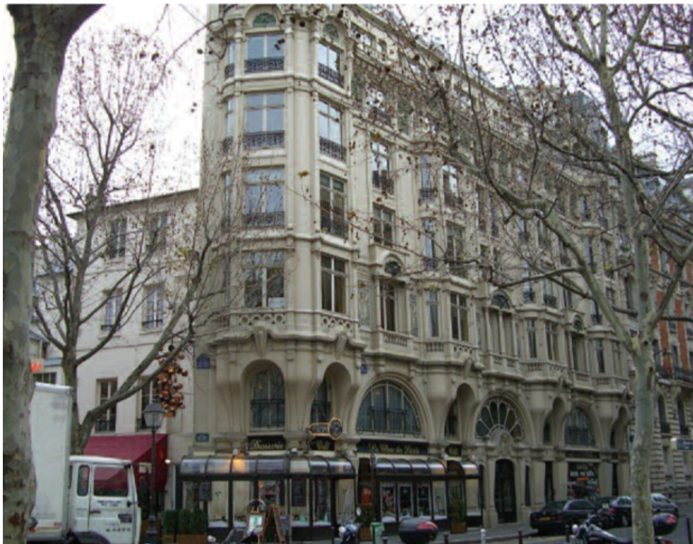
Figura 1: Edifício Hennebique. Rue Danton n.1. Quartier Latin, Paris, 1901. FONTE: HELENE; ANDRADE, 2010.
