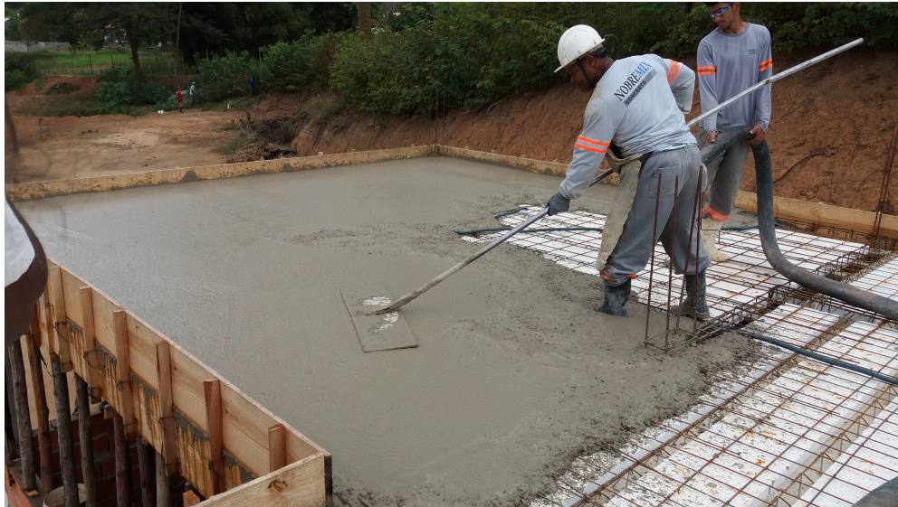
Figura 19: Execução do sarrafeamento da obra estudada FONTE: Acervo das autoras.
