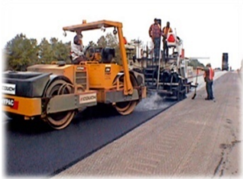
Figura 16: Rolo de placa vibratória Fonte: Bernucci et al (2008)
