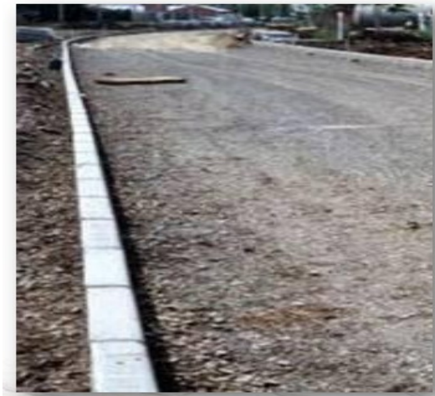
Figura 7: Execução das contenções Fonte: Associação Brasileira de cimento Portland (2013)
