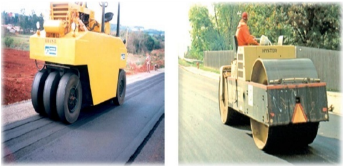
Figura 15: Rolos de pneus e rolo tandem liso Fonte: Bernucci et al (2008)
