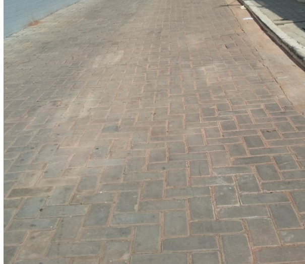
Figura 18: Pavimento intertravado Supermercado do Irmão Fonte: Acervo do Autor
