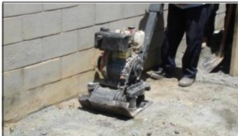
Figura 5: Nivelamento e compactação do subleito Fonte: Maski (2013)
