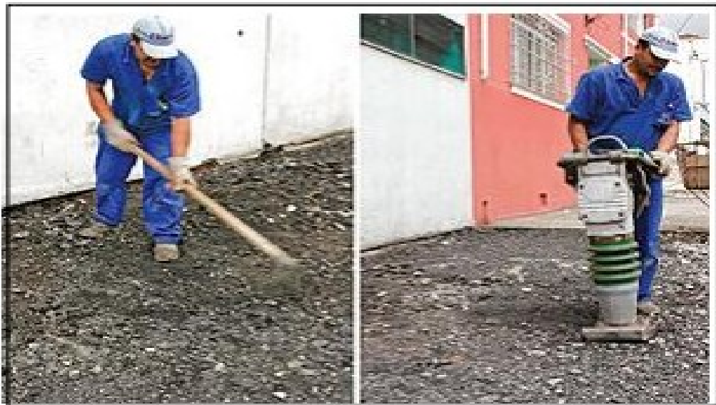
Figura 6: Execução das camadas inferiores Fonte: Equipe de Obra (2013)
