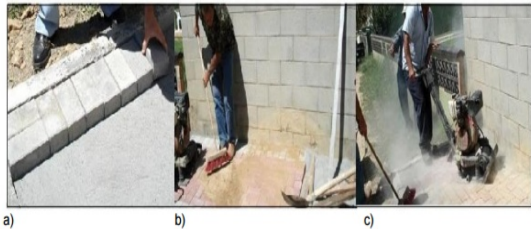
Figura 10: Etapas finais de execução do pavimento Fonte: Adaptado de Maski (2013)
