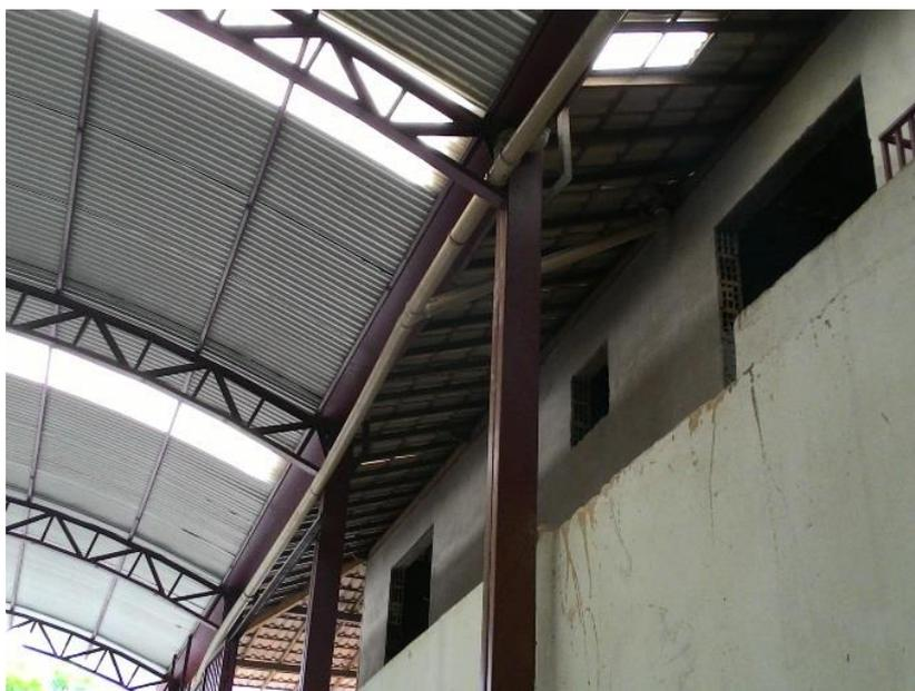
**Figura 33:** Demonstração e calhas e condutores existentes na empresa
