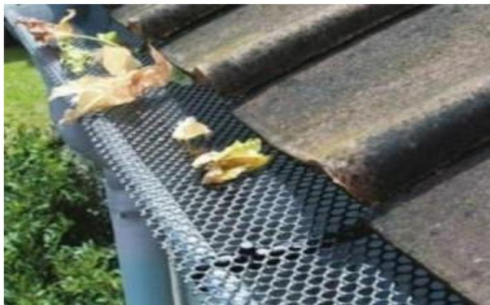
**Figura 4:** Tela para remoção de detritos.
