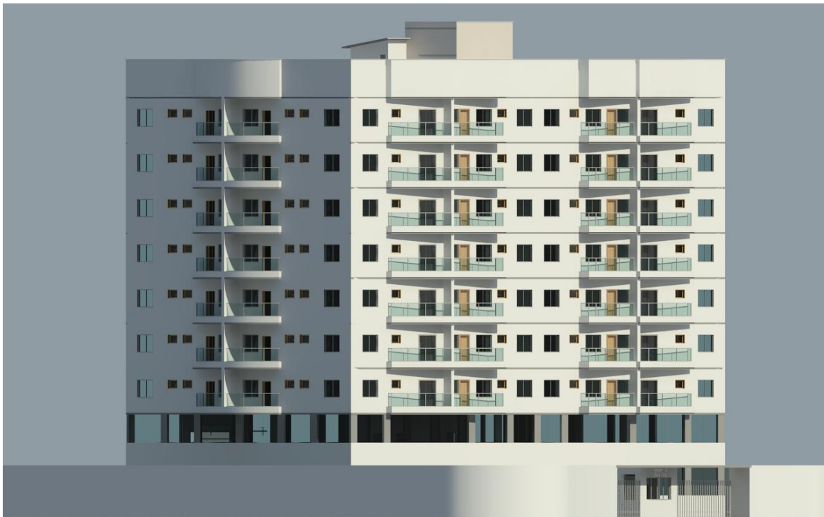
Fachada do edifício. Fonte: Autoria Própria.
