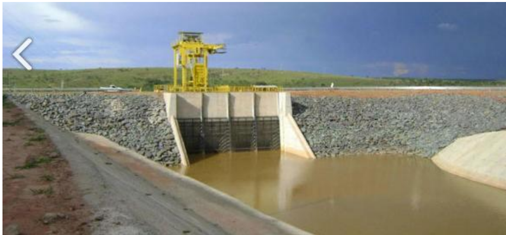
Figura 4 - Tomada d'água - UHE Retiro Baixo
