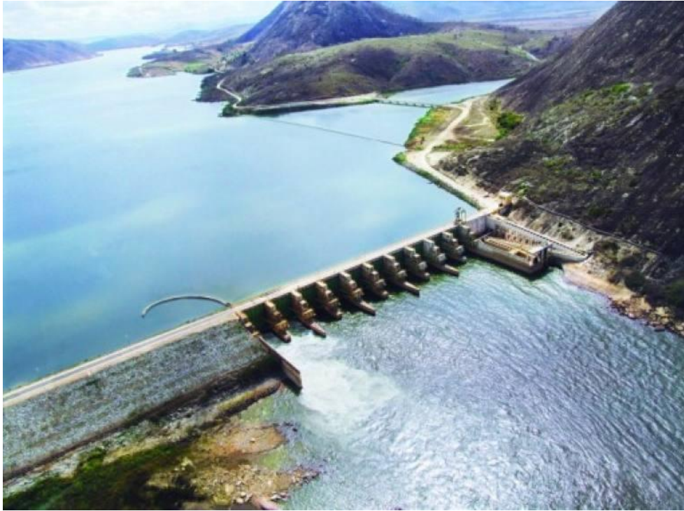
Figura 2: Extravasores da UHE Aimorés
