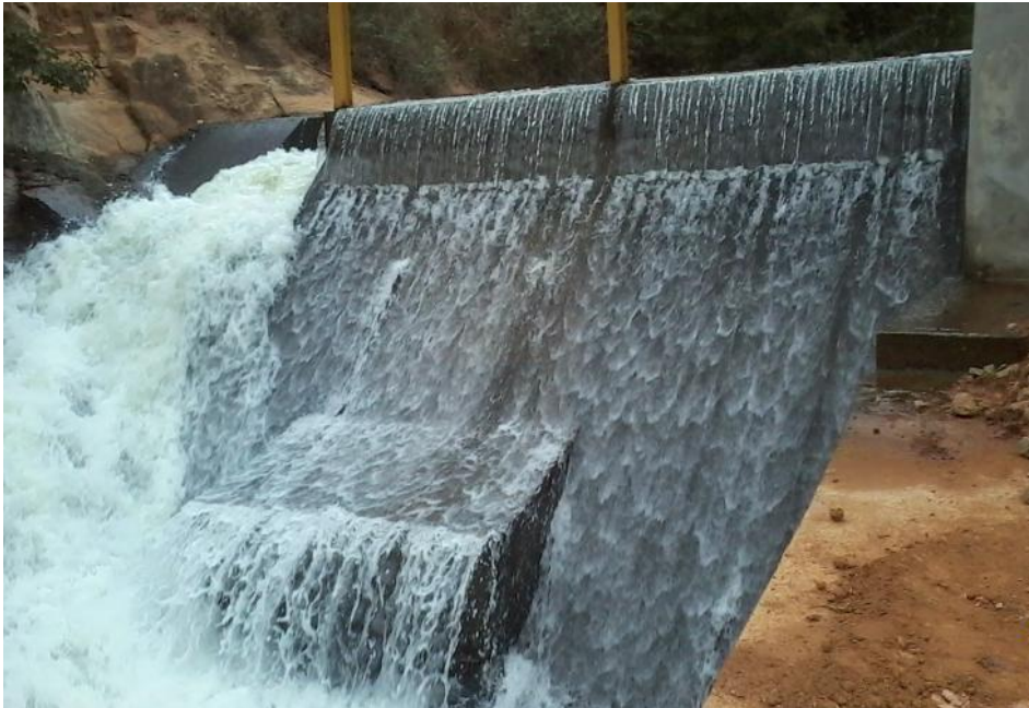
Figura 1- Barragem de Concreto CGH Bom Jesus
