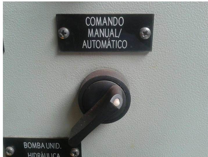
Figura 30: Botoeira para habilitar ou desabilitar função de comando automático foi instalada
