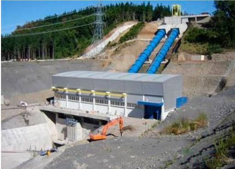
Figura 7–Casa de Força UHE Quilleco-Chile
