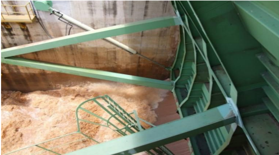
Figura 3 - Comporta do extravasor- UHE Aimorés
