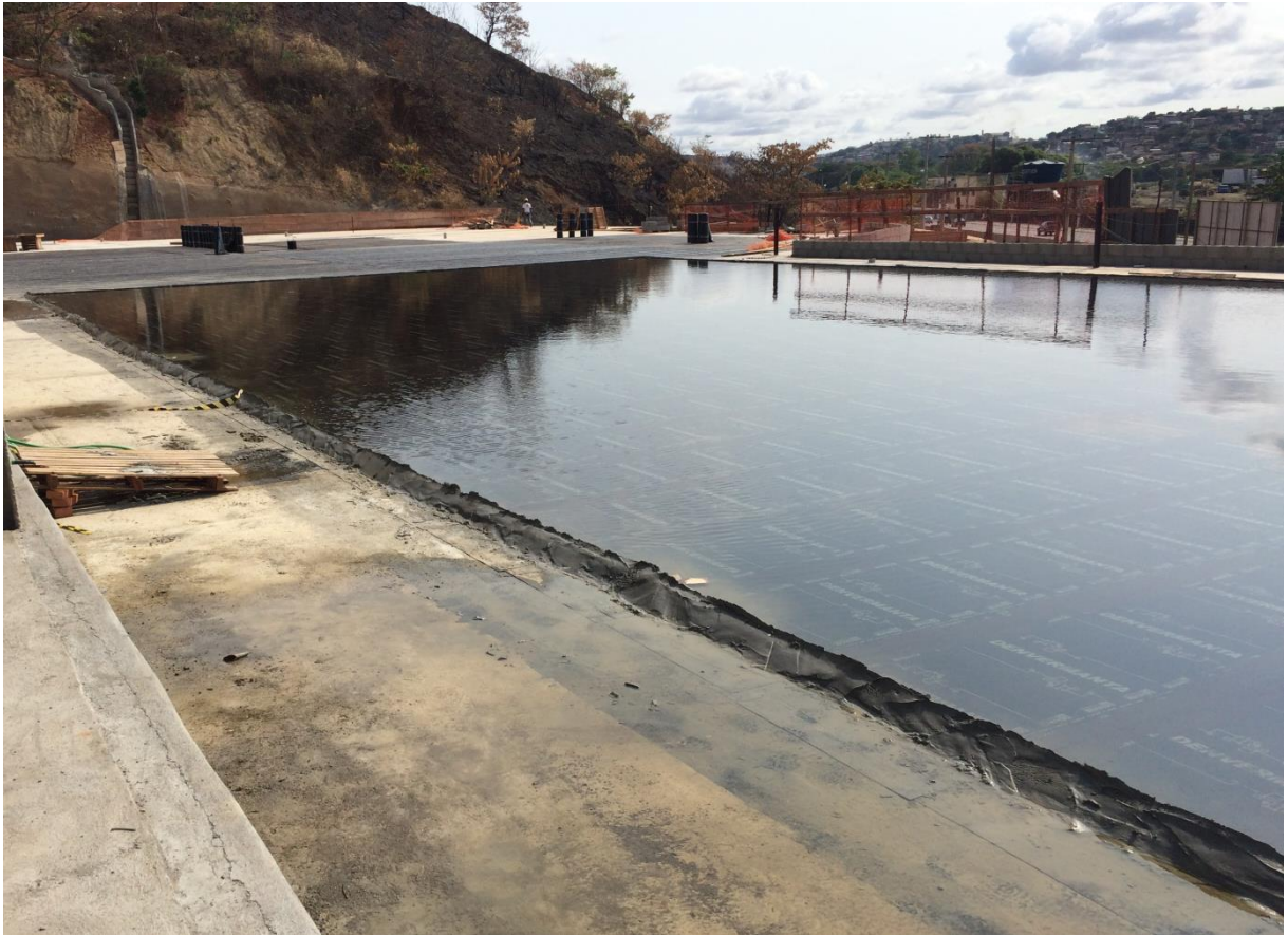
Figura 32: Teste de estanqueidade para identificar possíveis vazamentos na impermeabilização.
