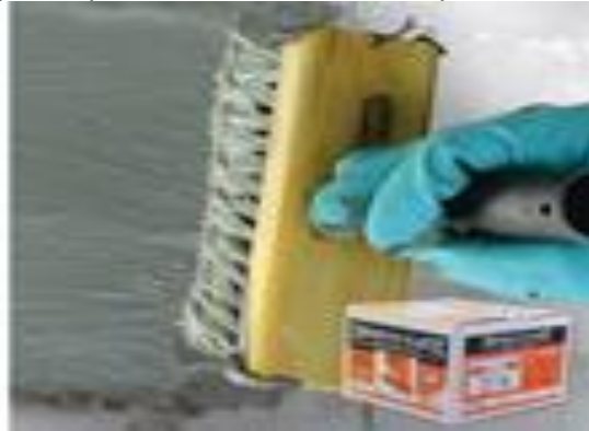
Figura 18: Impermeabilização da parede com membrana de polímero modificada com cimento.
