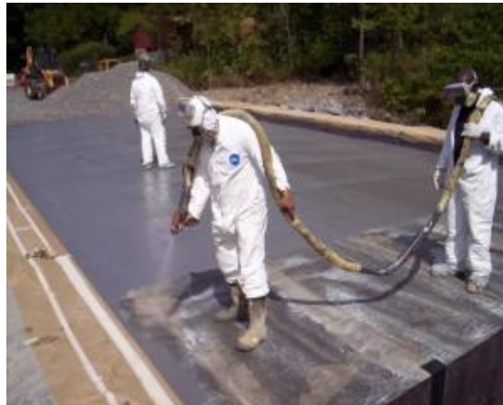
Figura 21: Membrana poliuréia sendo executada em uma laje.
