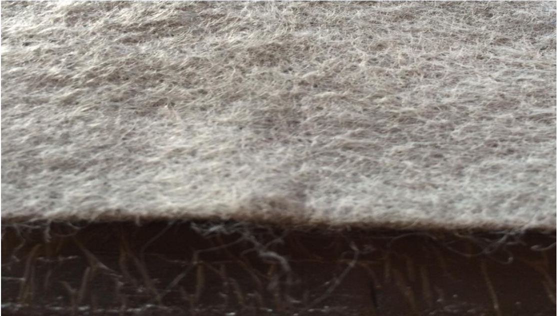
Figura 33: Camada de separação colocada sobre a manta asfáltica.
