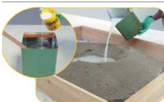
Figura 14: Preparação da argamassa com aditivo hidrófugo.
