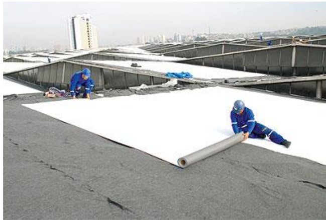
Figura 20: Execução de manta de PVC em laje.
