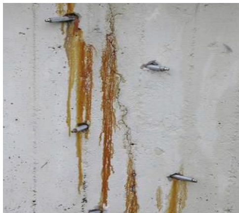
Figura 15: Vedação de fissuras com resina epóxi.
