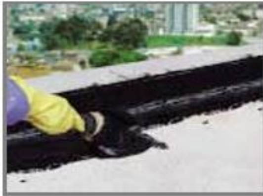
Figura 16: Aplicação da última demão da membrana na laje.
