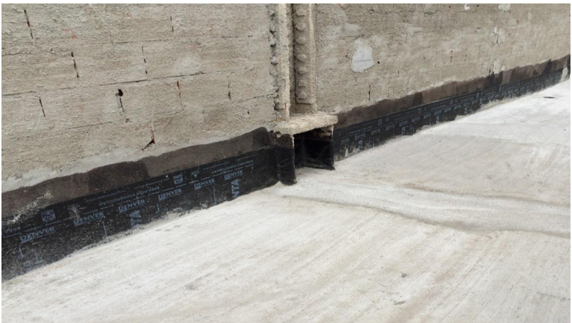
Figura 34: Proteção mecânica primária finalizada.
