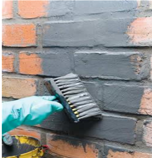
Figura 13: Cristalizante aplicado em forma de pintura.
