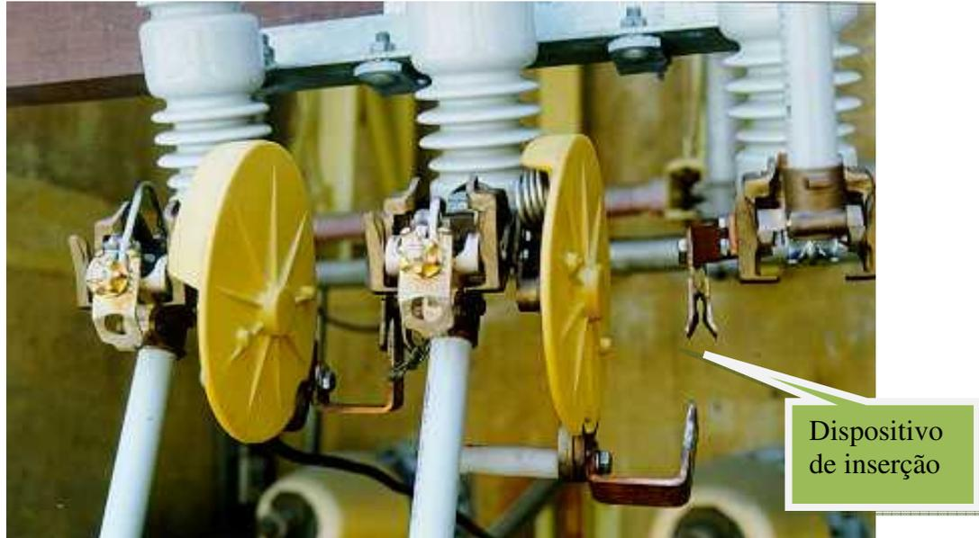
Figura 10: Sistema de inserções da chave fusível repetidora
