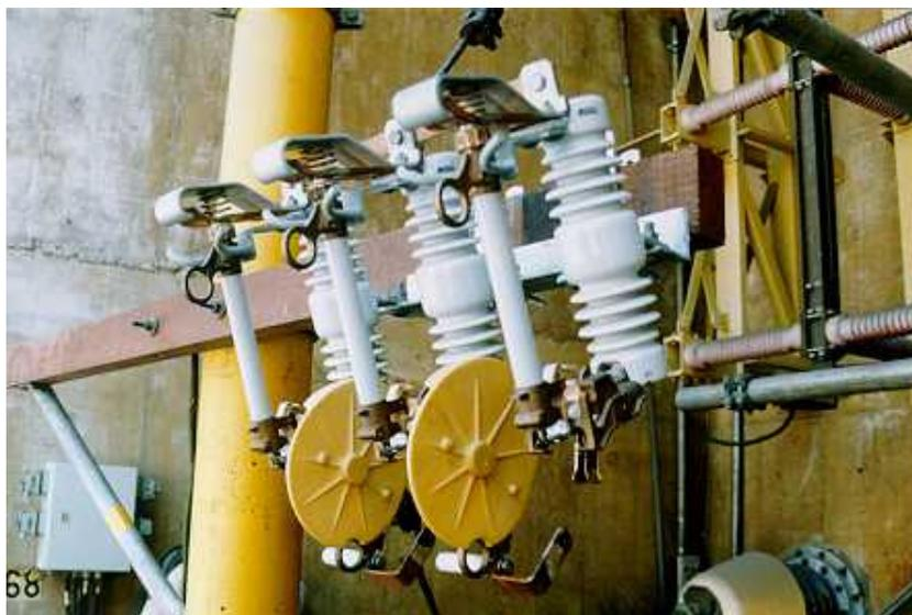
Figura 7: chave fusível repetidora.
