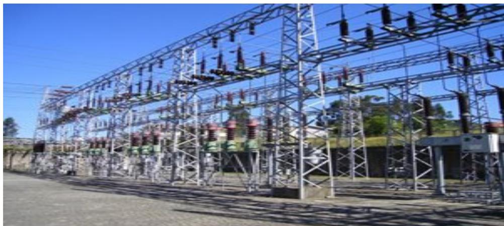
Figura 2: Subestação primária abaixadora
