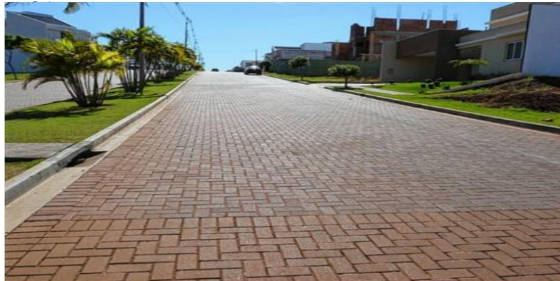
Figura 16: Exemplo de pavimentação com blocos paver na cidade de Maringá/PR 44
