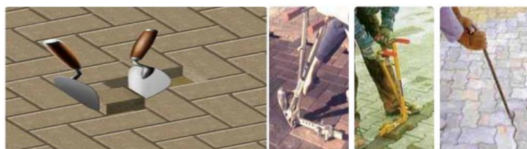
Figura 18: Formas de retirar blocos intertravados de concreto 48
