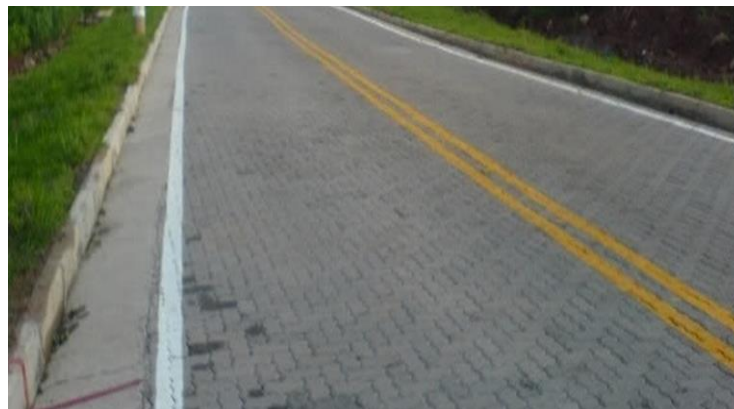
Figura 15: Exemplo de pavimentação com blocos de 16 faces na cidade de Campinas/SP 43
