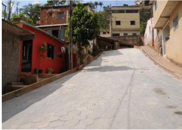
Figura 14: Exemplo de pavimentação com blocos sextavados na cidade de Manhumirim/MG 42
