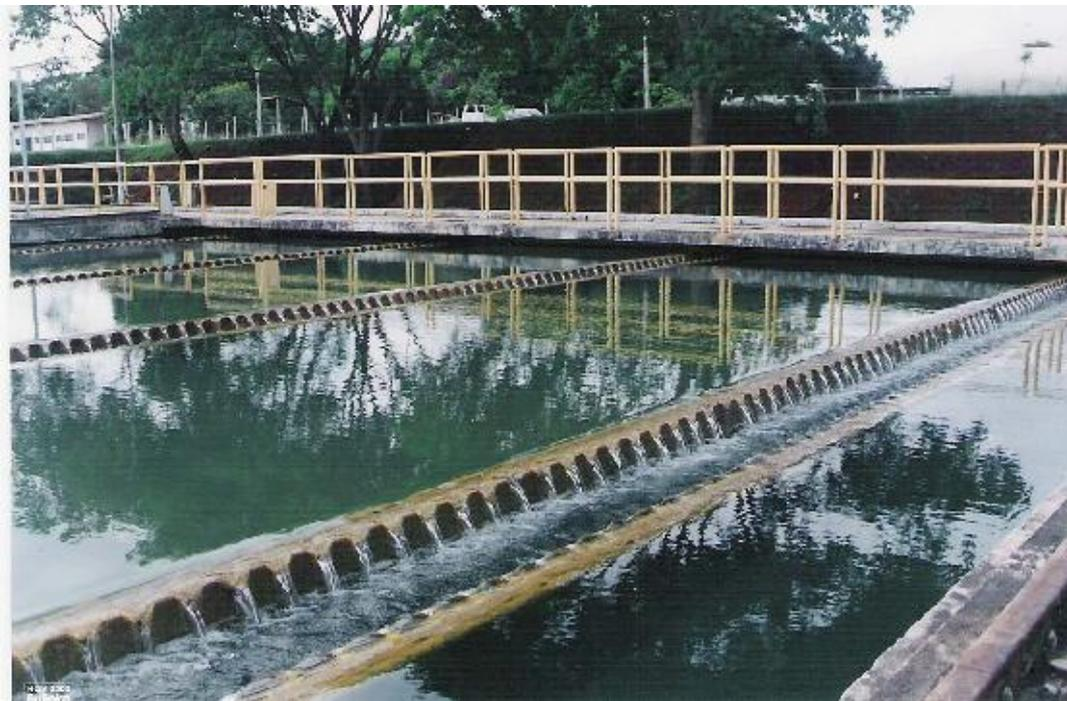
Figura 2 - Detalhe das Calhas que recebem a água decantada
