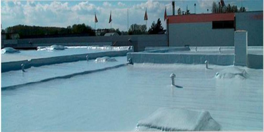
Figura 13 aplicação da membrana acrílica
