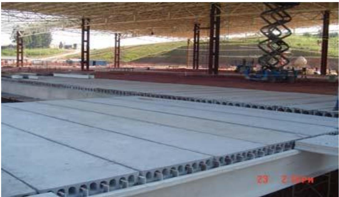
Figura 10 laje pre-moldada alveolares.
