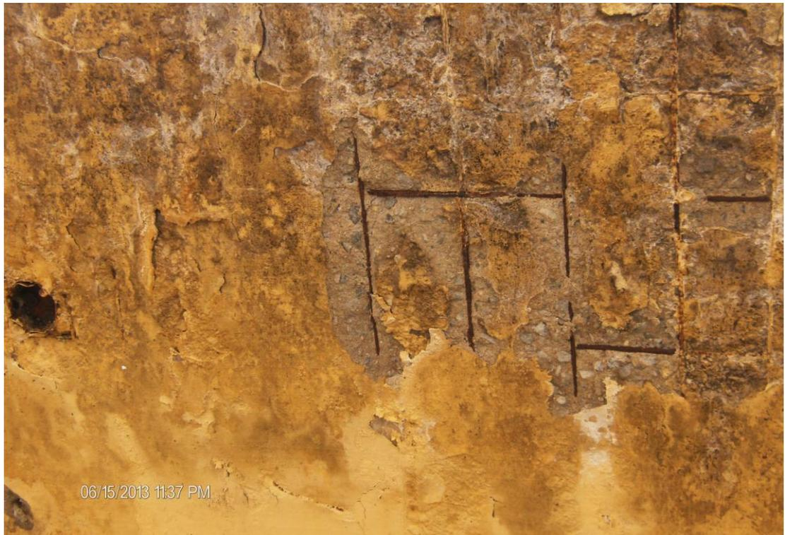
Figura 03 ilustrando a ferrugem nas armaduras
