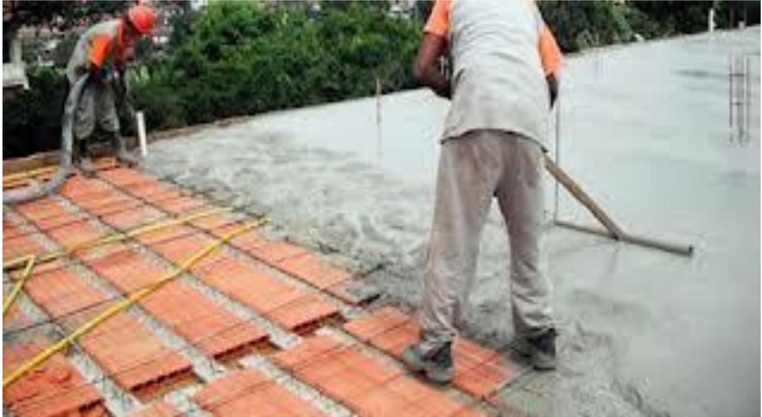
Figura 07 laje pre-moldada com lajotas cerâmica
