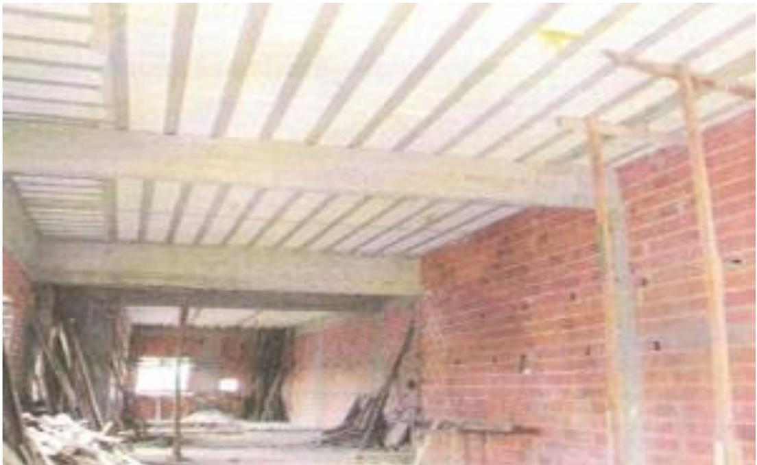
Figura 08 lajes pre-moldada com lajotas de isopor
