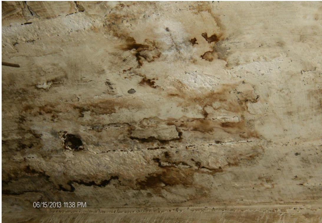
Figura 01 ilustrando o bolor causado no interior da edificação
