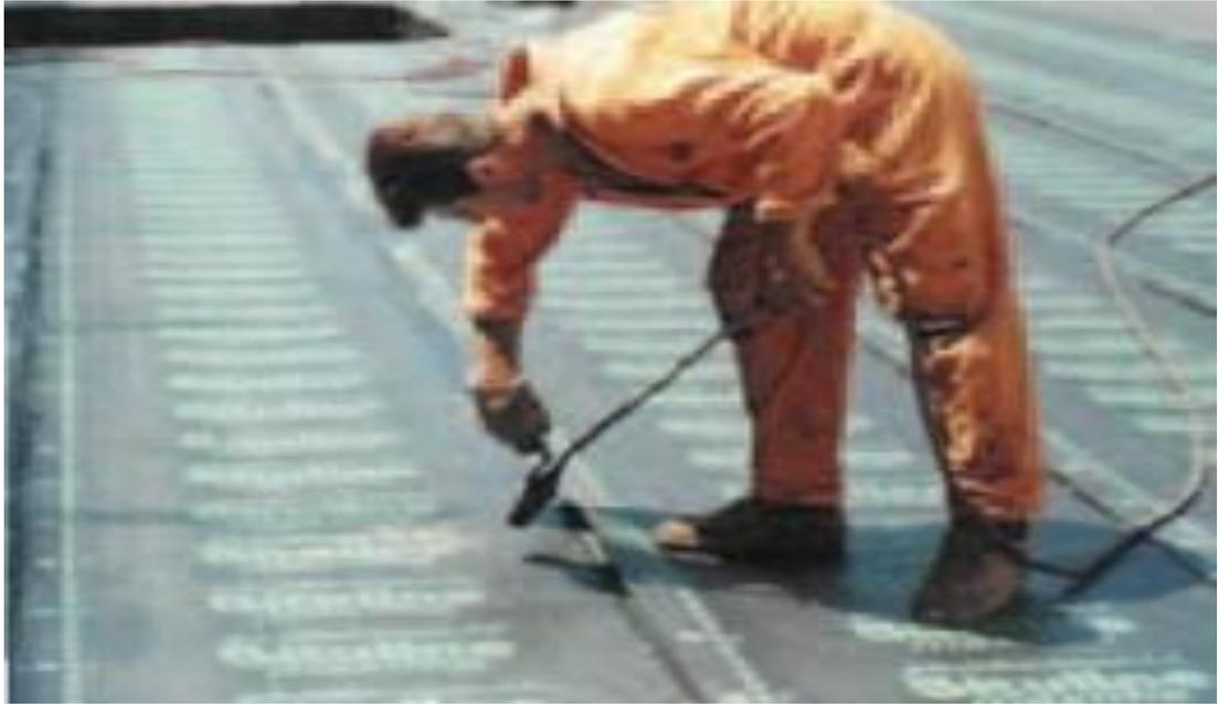
Figura 15 fazendo as emendas com maçarico
