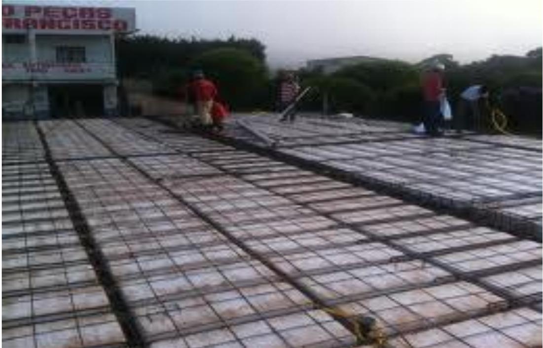
Figura 09 laje pré-moldada de painéis treliçados.
