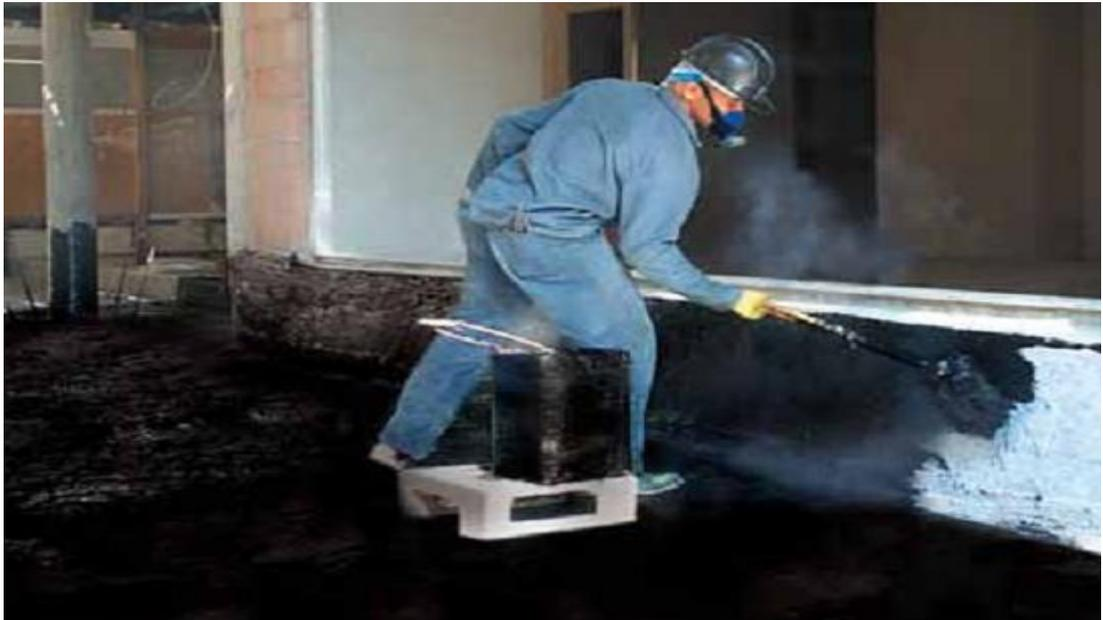
Figura 12 aplicação da membrana asfáltica a quente.
