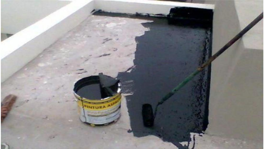
Figura 11 Aplicação da membrana asfáltica a frio
