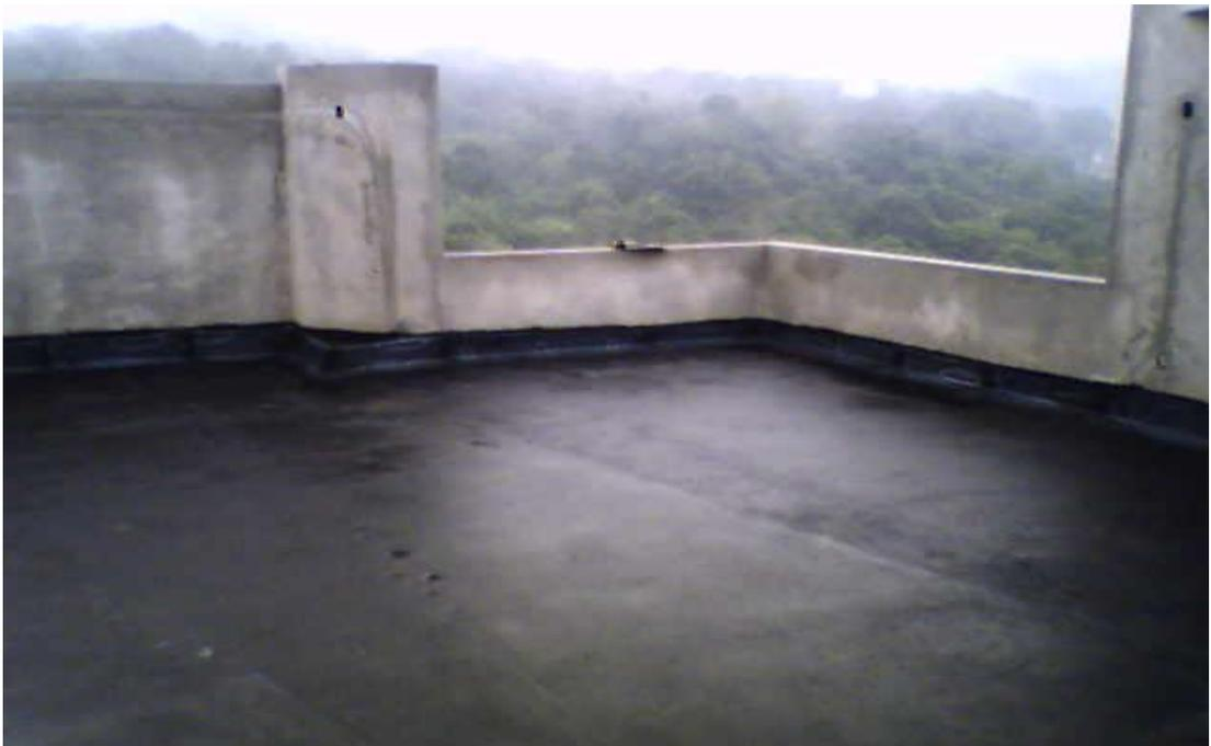
Figura 14 aplicação do primer sobre a superfície
