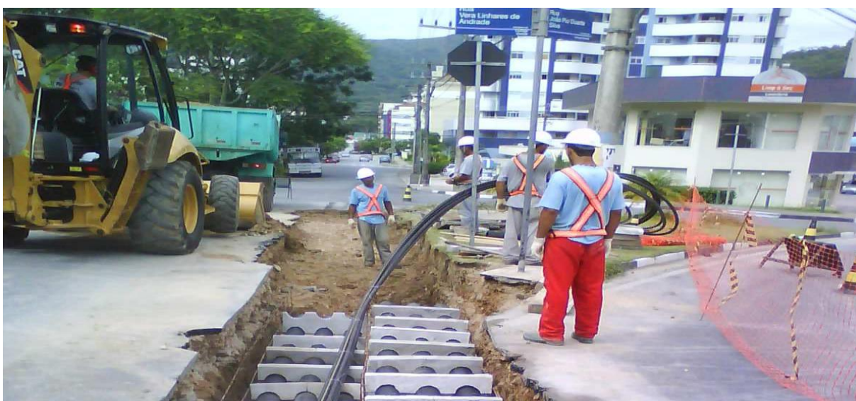
FIGURA 6 – Implementação de rede subterrânea
