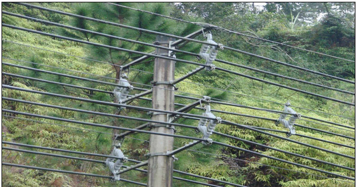
FIGURA 3 - Rede Aérea Compacta Fonte: < http://www.copel.com >
