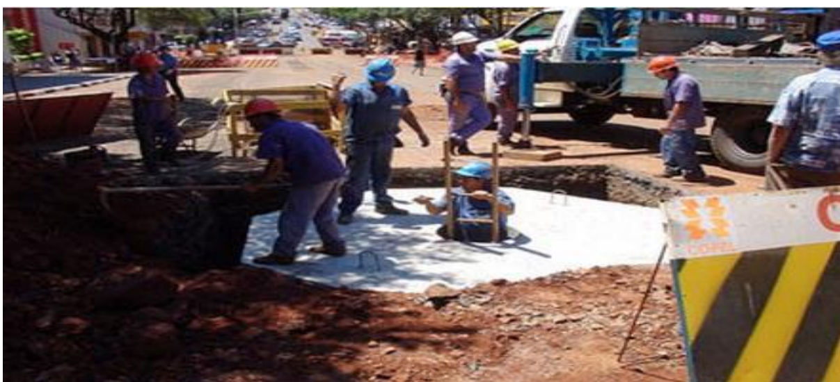
FIGURA 20 – Caixa de Inspeção
