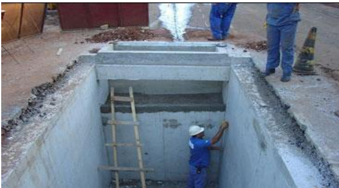
FIGURA 19 – Câmara transformadora em construção
