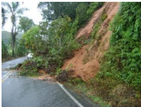
FIGURA 5.2 – ESCORREGAMENTO EM BARBACENA/MG, NA MG 135 SAÍDA PARA ANTÔNIO CARLOS, NA ALTURA DO KM 06.
