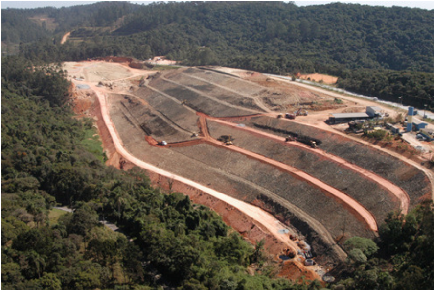
FIGURA 7.3 RETALUDAMENTO EM RODOVIA DE BAURÚ/SP.
