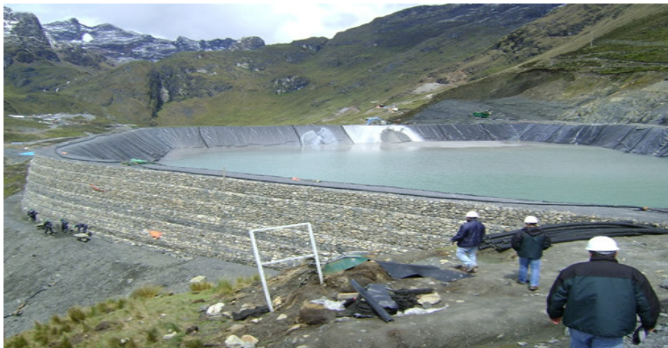
Figura 25: barragem alçada com muro gabião.
