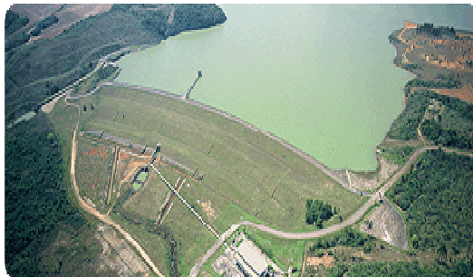
Figura 22: Barragem do rio Verde
