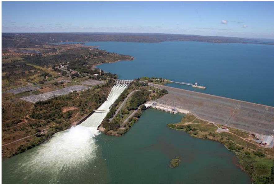
Figura 23: Barragem de Três Marias
