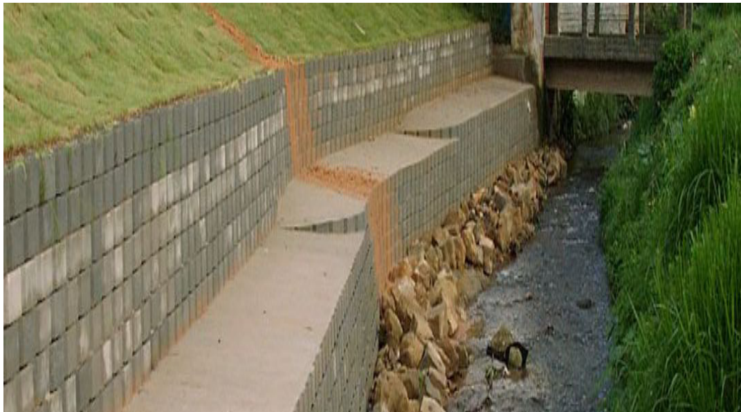
Figura 24: Imagem de solo reforçado
