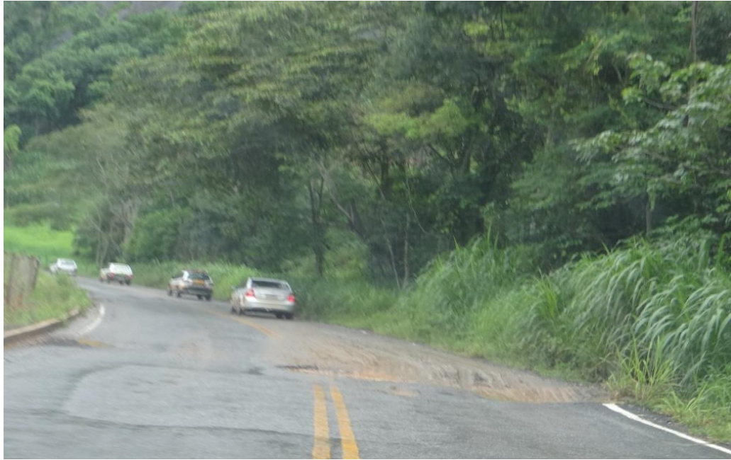
Figura 10 - Comprometimento de uma das vias da pista por buracos, falta de acostamento e drenagem. http://www.giro21.com.br/mat_vis.aspx?cd=6519
