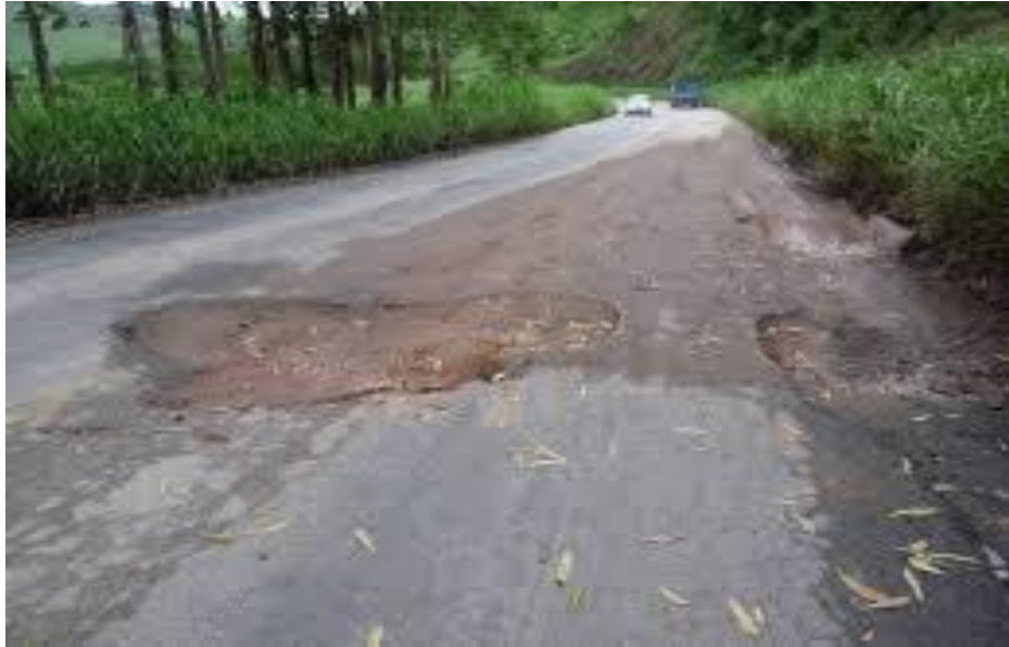
Figura 8 - Comprometimento de parte da pistas por buracos, falta, neste trecho sinalização horizontal, acostamento e drenagem. http://www.giro21.com.br/mat_vis.aspx?cd=6519
