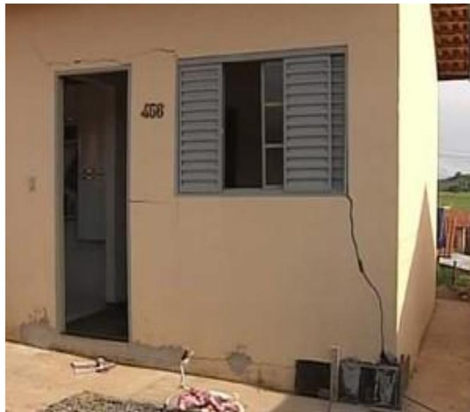
Figura 9: Rachaduras por má compactação do solo em Patos de Minas.
